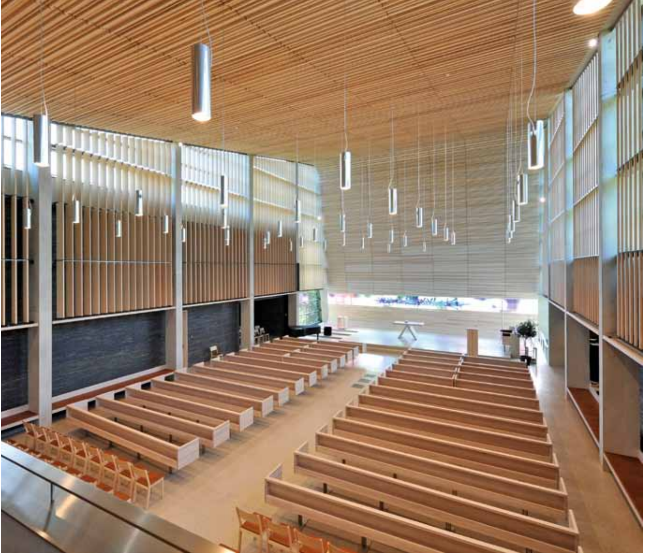
Himlingen i kirkesalen løfter seg mot den skrå endeveggen og gir salen retning. Trelamellene hindrer blinding fra sollys, regulerer daglys og sikrer god akustikk
