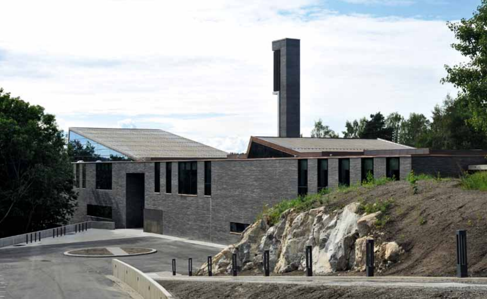
Østfasaden med hovedinngangen
