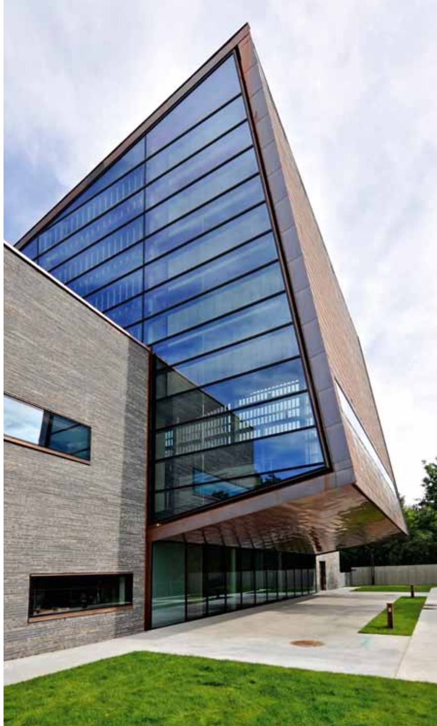
Barnehagen ligger i underetasjen mot syd-vest
