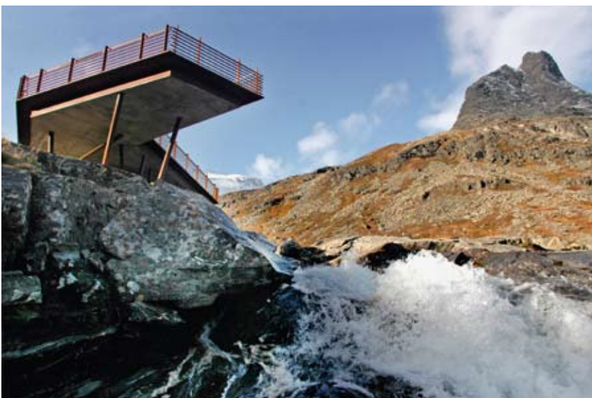
De dominerende materialer er plassenstøpt betong og stål, i hovedsak corténstål
