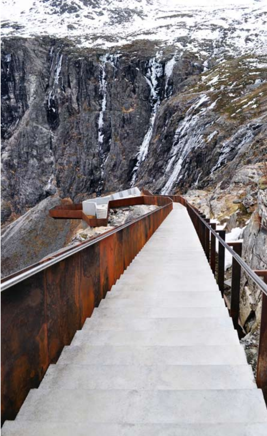
De dominerende materialer er plassenstøpt betong og stål, i hovedsak corténstål
