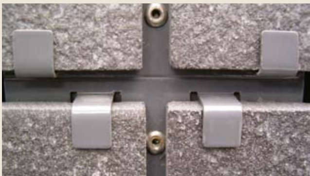
Figur 3b: Synlig innfesting med klips i samme farge som kledning
