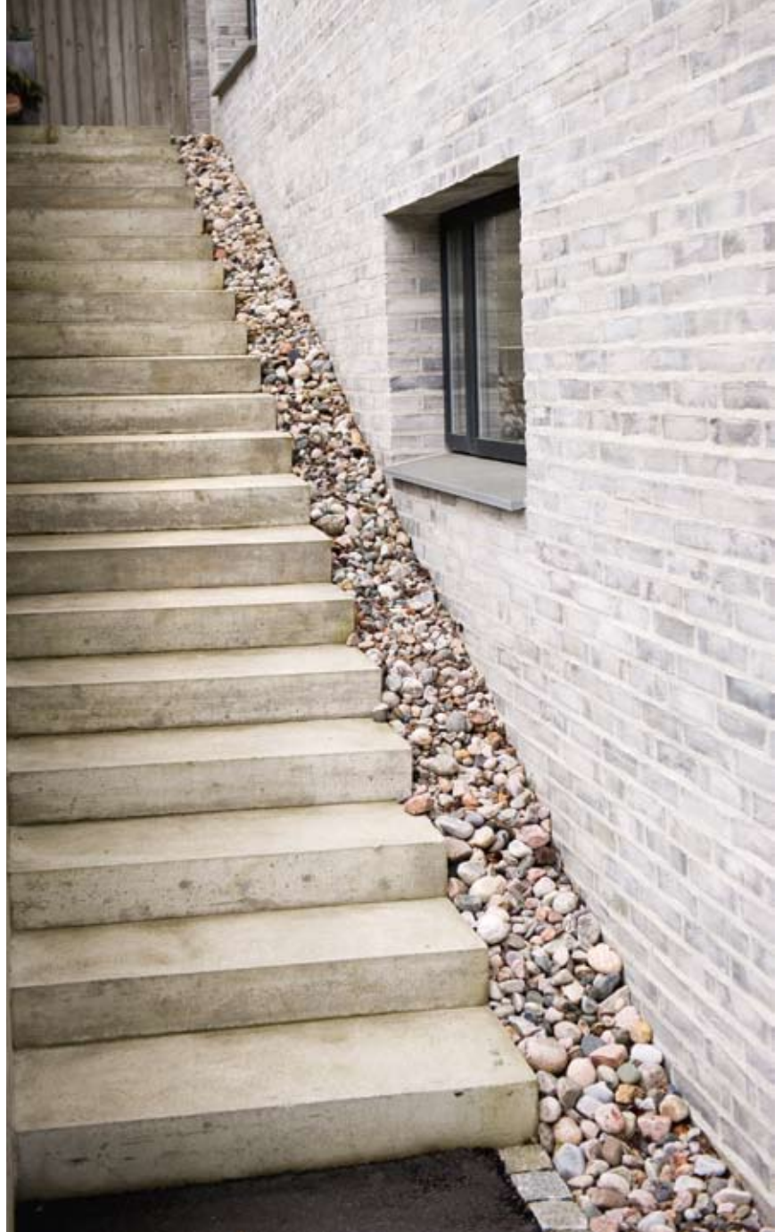
Teglsteinen er murt med lyse fuger
