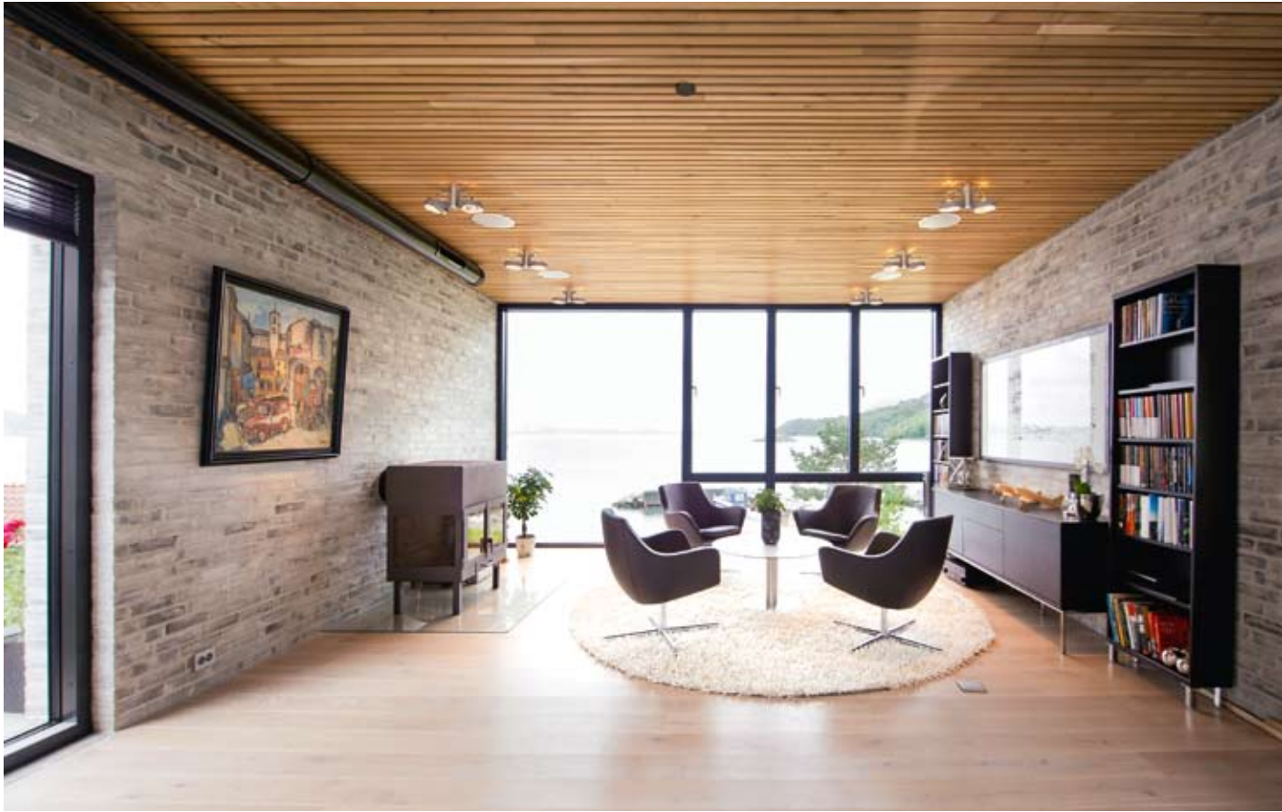
Stuen med de to bærende teglskivene og den store glassfasaden mot utsikten i nord
