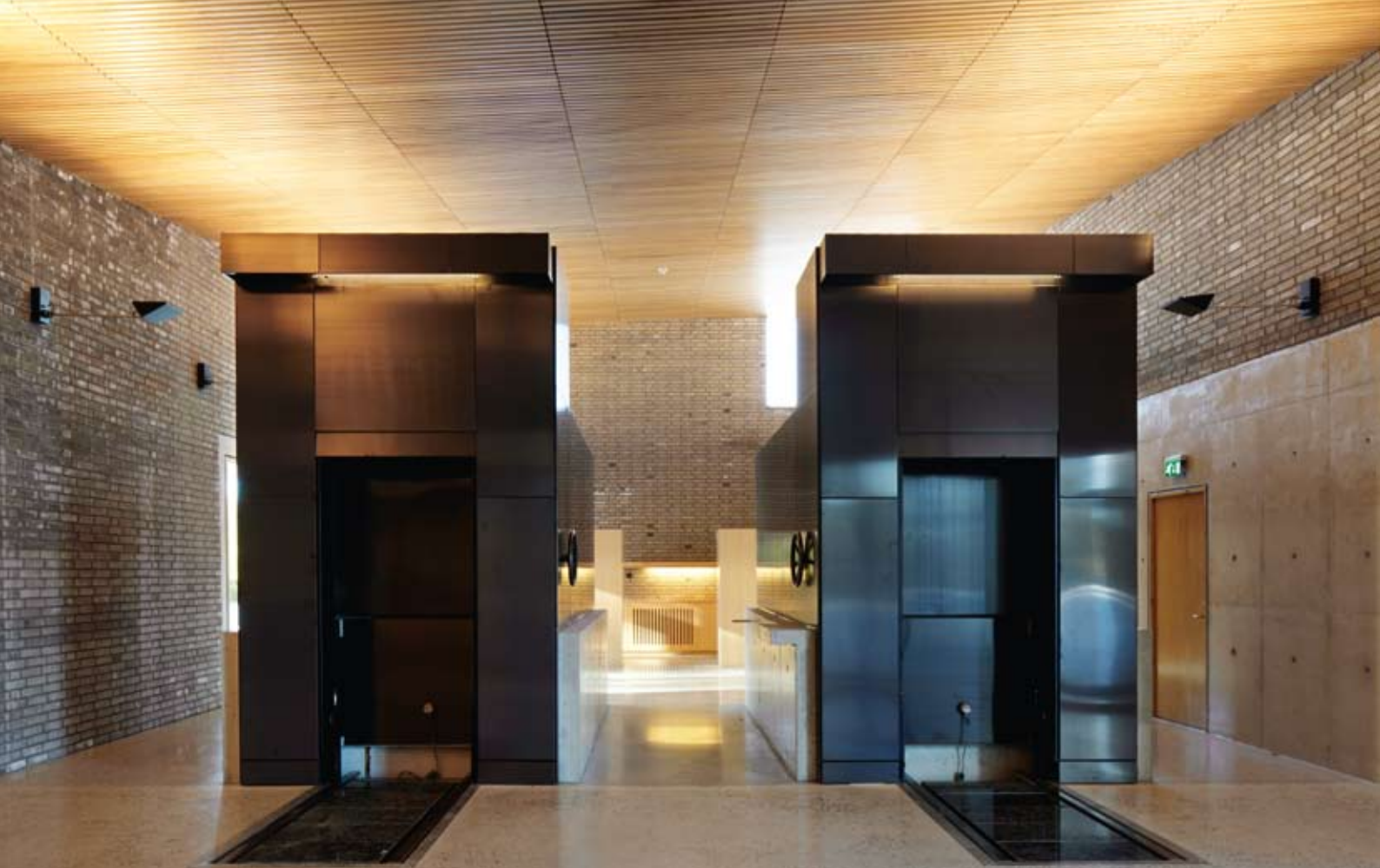
De to krematorieovnene er kledd med prepatinert kobber og står i en plasstøpt sokkel av lys betong. Det er spillehimling av ask i alle rom
