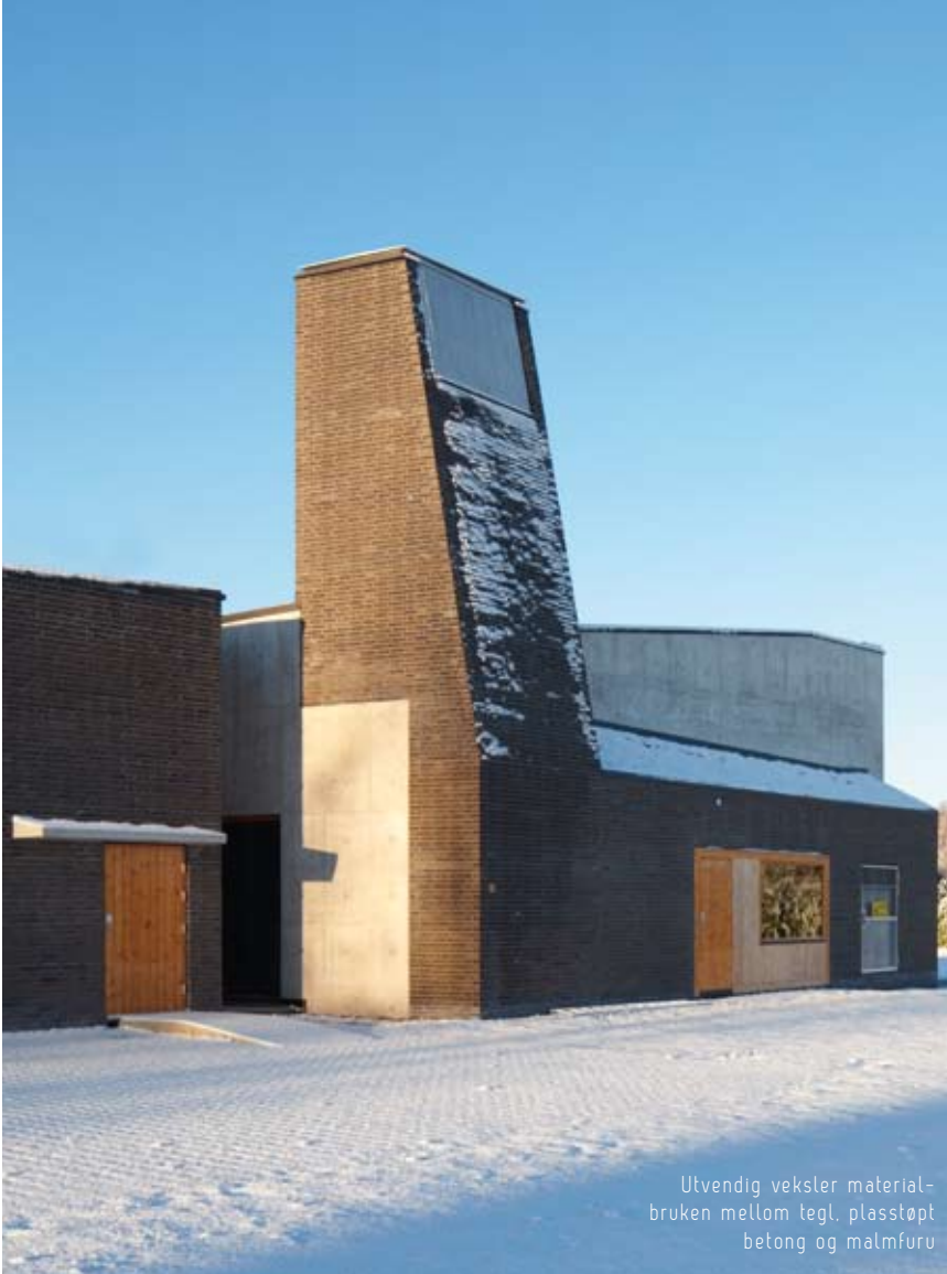
Inngangsparti for besøkende sett fra skogkanten. En vegg av tegl murt i åpent forbandt lager en skjermet hage utenfor seremonirommet
