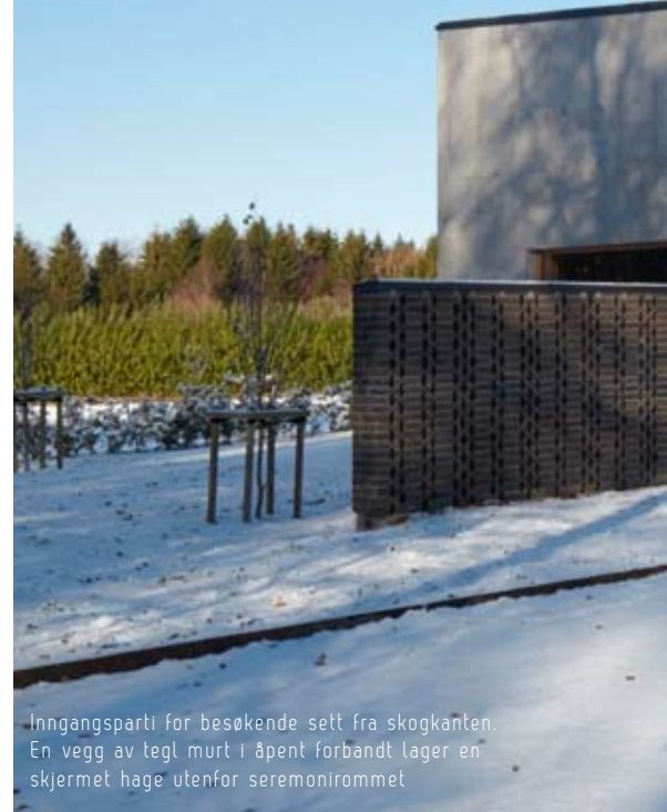
Utvendig veksler materialbruken mellom tegl, plasstøpt betong og malmfuru
