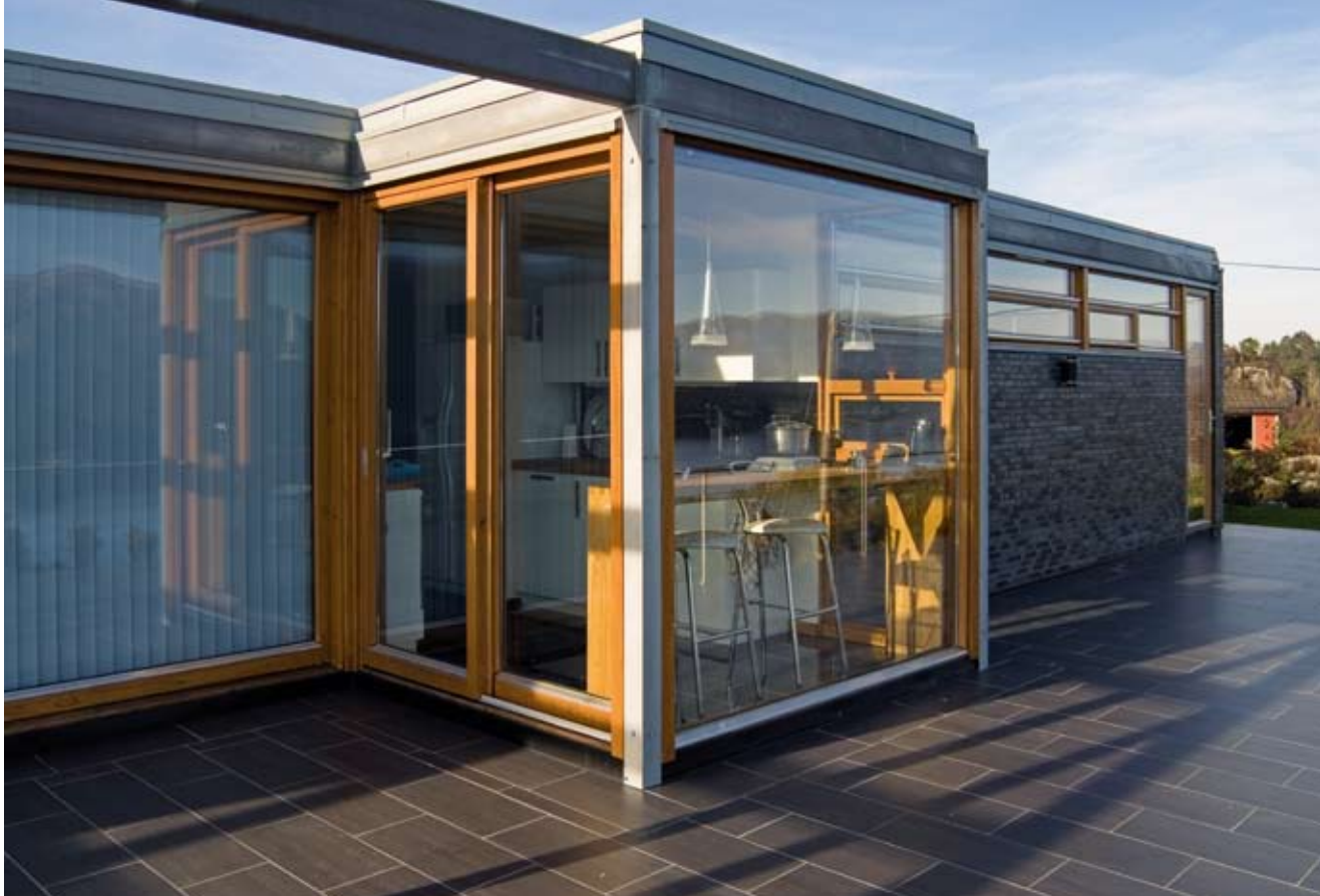
Teglsteinen har et rikt fargespill i gråsvarte toner og kommer i et helt spesielt format: l x b x h = 240 x 90 x 40 mm
