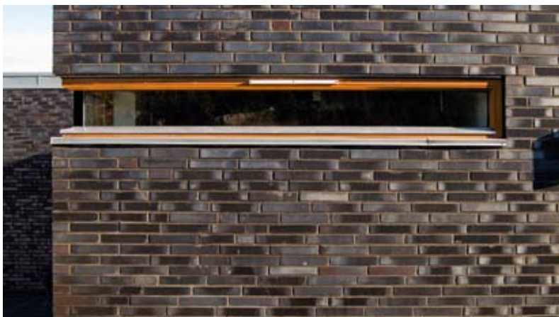
Teglsteinen har et rikt fargespill i gråsvarte toner og kommer i et helt spesielt format: l x b x h = 240 x 90 x 40 mm
