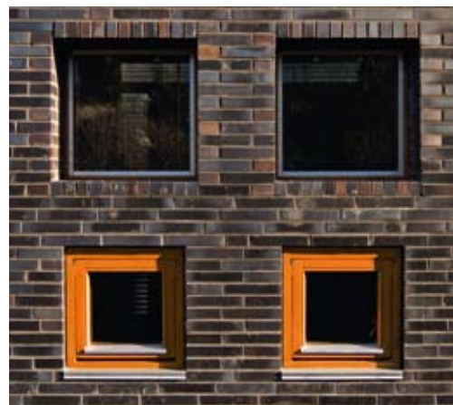
Teglsteinen har et rikt fargespill i gråsvarte toner og kommer i et helt spesielt format: l x b x h = 240 x 90 x 40 mm
