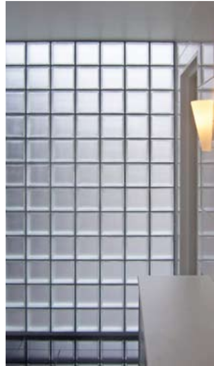
Glassbygggesteinsvegg på badet
