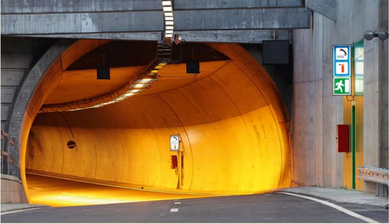
Tunnelåpningene gir de hardeste påkjenningene på materialene: vann, frost, støv, temperaturvekslinger. Foto: Morten Knudsen ©Knudsens Fotosenter
