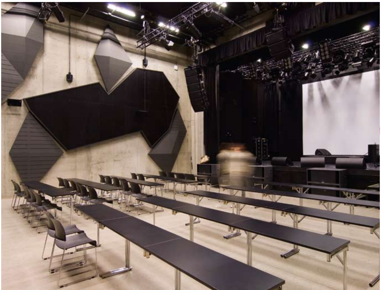
Fra musikkscenen, der eksponert betong sammen med nøye prosjekterte absorberer og reflektorer har gitt optimale akustiske forhold
