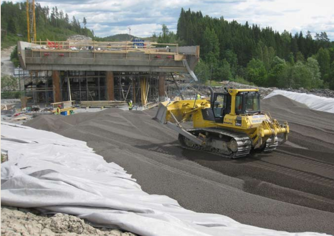
Lett fylling: Bildet viser en fylling med usortert lekklinker i overgangen inn mot en bro. Massen er tippet på plass og fordeles og komprimeres med doser. E18, Spydeberg. Askim entreprenør
