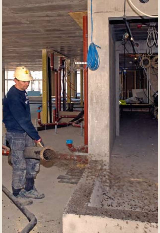
Lett gulv: Til avretting av gulv eller der rørføringer er lagt i etasjeskiller kan lettlinker blåses inn til ønsket høyde før gulv støpes eller flytsparkel legges ut. Bildet viser et eksempel der innblåsningen ble gjort i 11. etasje i -23 °C på en solrik vinterdag. Tjuvholmen, Aker brygge i Oslo, prosjekt Georg Andresen & sønner
