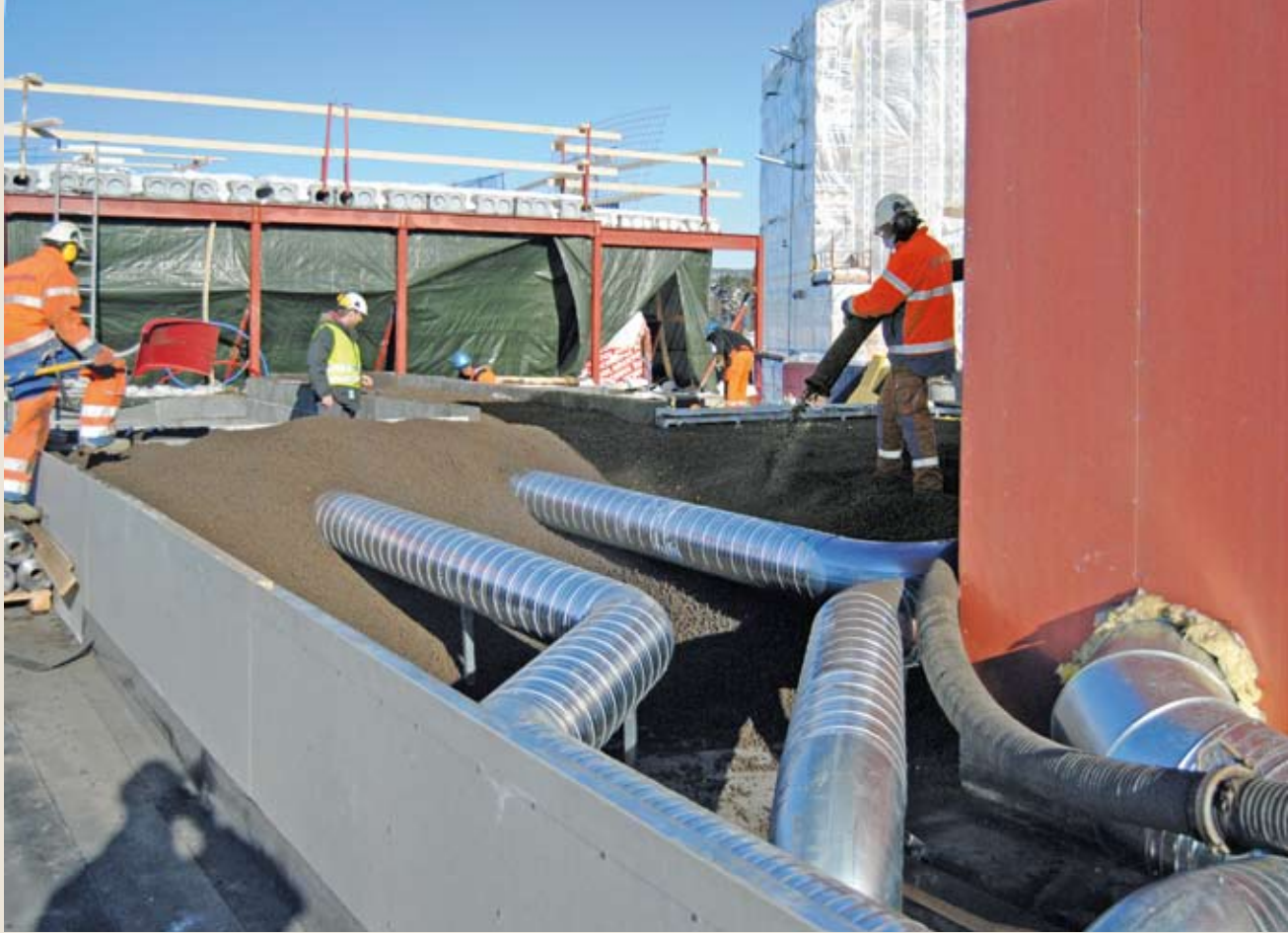
Inndekking av ventilasjonsanlegg på tak. Ventilasjonen er kasset inn Lettklinker blåses opp under, rundt og over rørene som beskyttelse. Inndekking og isolasjon. Fra det nye kulturhuset i Lørenskog kommune. Skanska.
