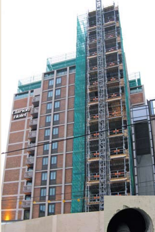
Brannsikring av heissjakter: De gamle heissjaktene skulle blindes og ble fylt med lettlinker fra toppen, ca 35 meter over bakken. Royal Christiania, Oslo. AF
