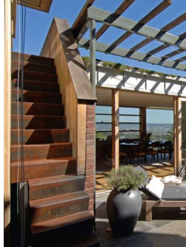
Fra atriet. Spisestue innenfor den store skyvedøren. Trapp av cortenstål leder opp til veranda utenfor soveromsfløy på plan 2.
