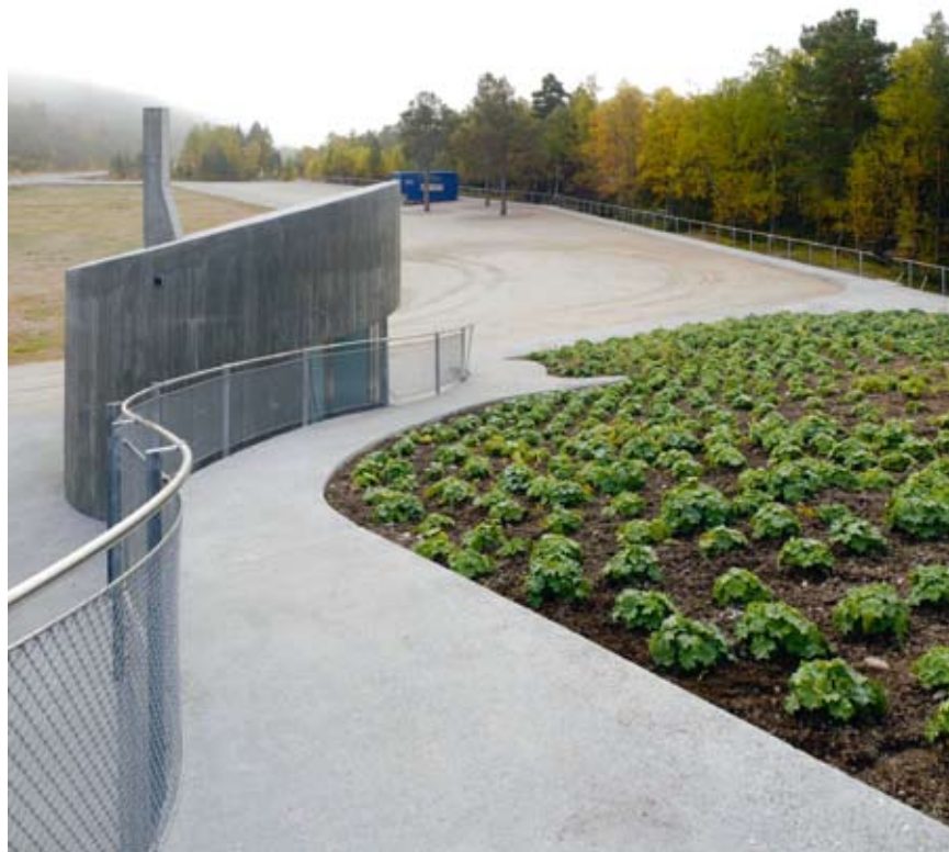
Varmestuen har en lukket side mot parkeringsplassen, der et beplantet skråplan fører til takterrassen med utsikt mot fjellene
