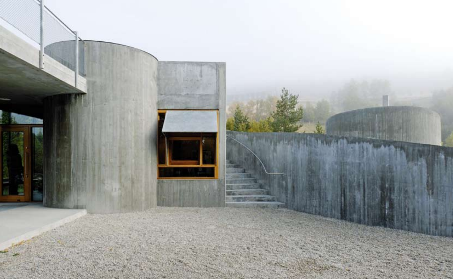
Fra gårdsplassen, med inngang til varmestuen, kioskluke og trapp til takterrassen. Kiosken henvender seg både til varmestuen og til uteområdet og kan avstenges med et rullegitter slik at varmestuen kan holdes åpen uten betjening
