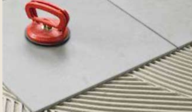
Figur 3: Bruk av vakumløfter letter arbeidet for flisleggeren
