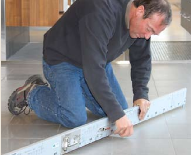
Figur 3: Bruk av vakumløfter letter arbeidet for flisleggeren
