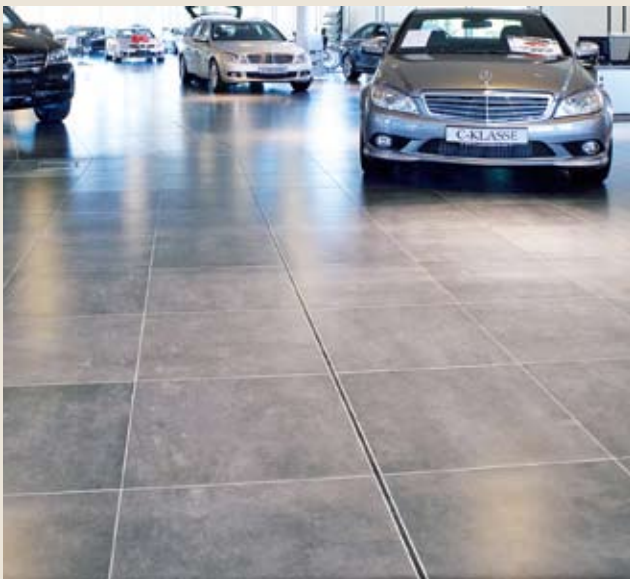
Figur 6: Metall fugeprofiler benyttes på flater som har rullende trafikk
