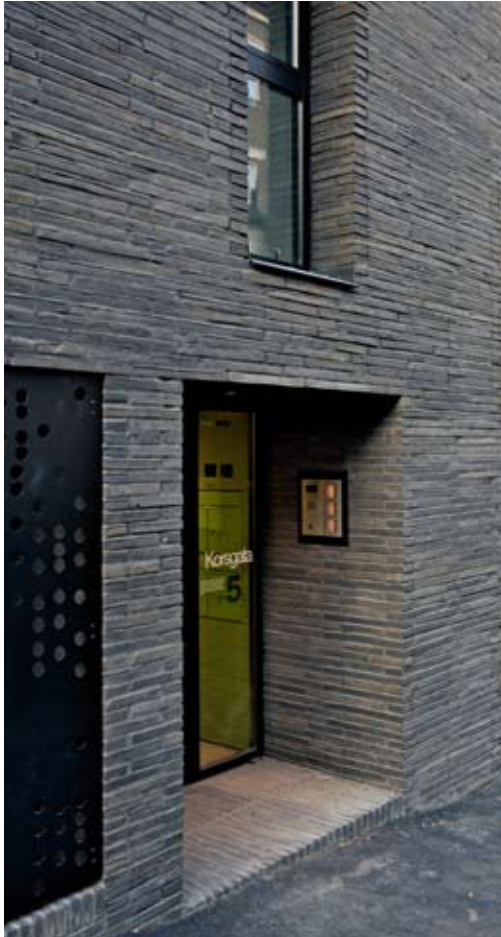
Den avlange, sorte, håndbankede teglsteinen av typen Kolumba ble utviklet i samarbeid med den sveitsiske arkitekten Peter Zumthor til Kolumbamuseet i Köln.
