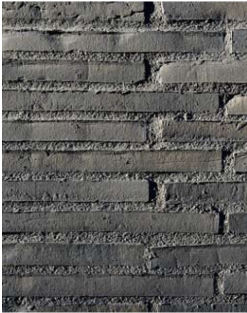
Den avlange, sorte, håndbankede teglsteinen av typen Kolumba ble utviklet i samarbeid med den sveitsiske arkitekten Peter Zumthor til Kolumbamuseet i Köln.
