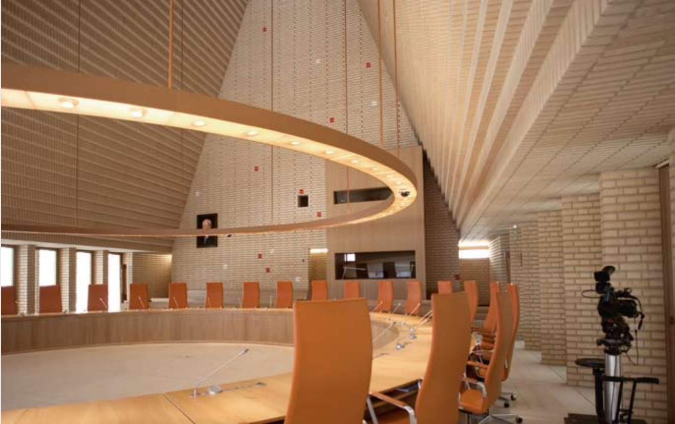
Varmgul tegl er brukt i vegger ute som inne, på under- og overdeknninger, på gulv og i tak, på uteplass og på steiltakets overflate
