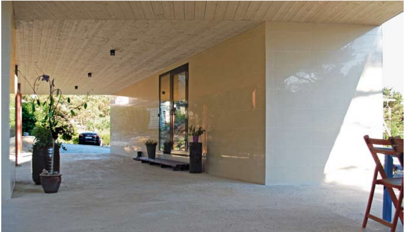
Uteområdet under tak er belagt med blanke, hvite fliser for å forsterke kvaliteten i husets utradisjonelle, men viktige oppholdsrom
