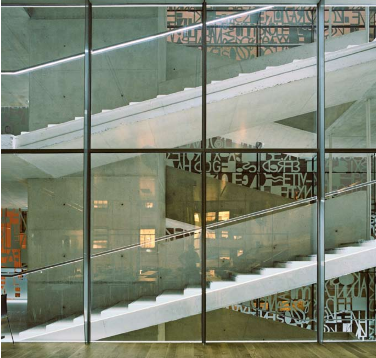
Hovedtrappen starter i lobbyen og spenner på tvers av volumet parallellt med glassfasaden. Lave, dype trinn understreker den langsomme bevegelsen
