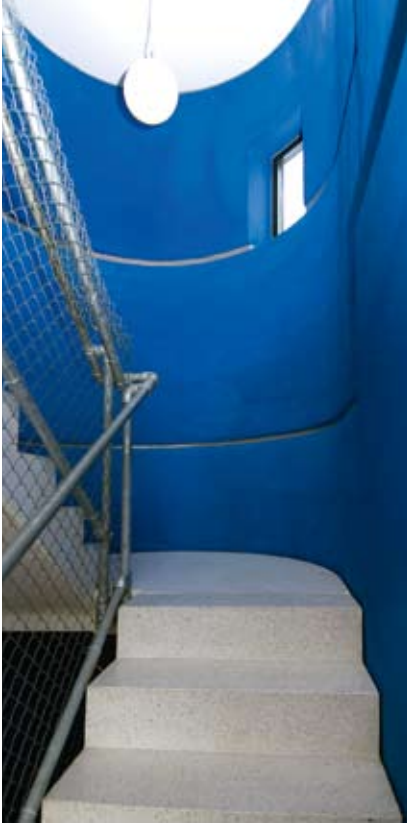
Det halvsirkelformete trapperommet er støpt i stående forskaling. Trapperom og vegg i atelier er i blåpigmentert betong med marmortilslag, mens trappen er i hvit, slipt marmorbetong.
