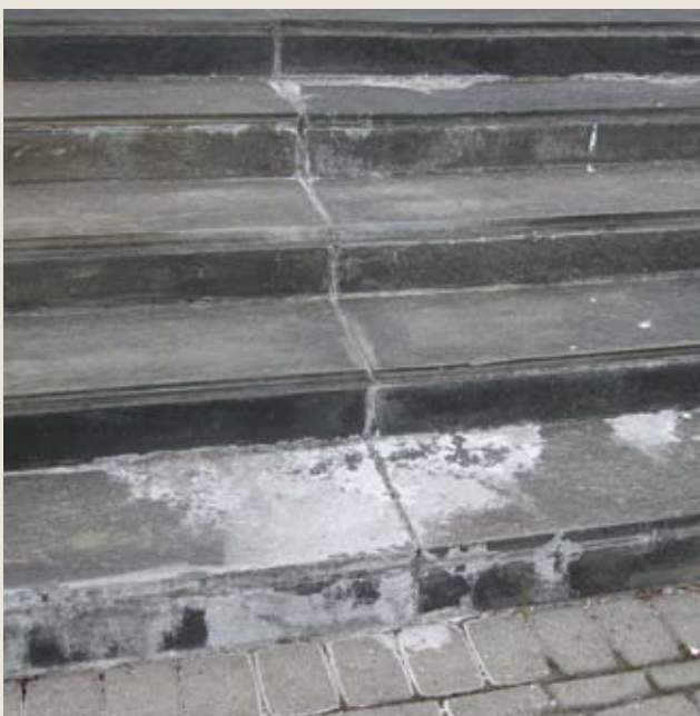
Figur 6 a og b: En membran under flisene/hellene ville minimert disse utfellingene
