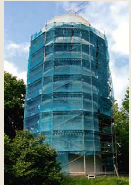
Stillaset ble dekket til for å hindre at regn forsinket karbonatiseringsprosessen
