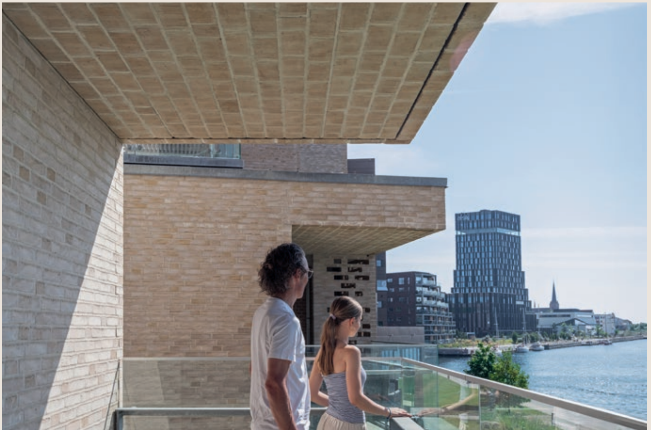
Der arkitekten ikke ønsker synlig stål i underkant, kan det monteres teglbejler med istørte skinner som festes i bakvegg/dekkeforkant – se figur 9. Teglelementer for himling produseres etter mål og ønsket forband og henges opp i balkongdekket
