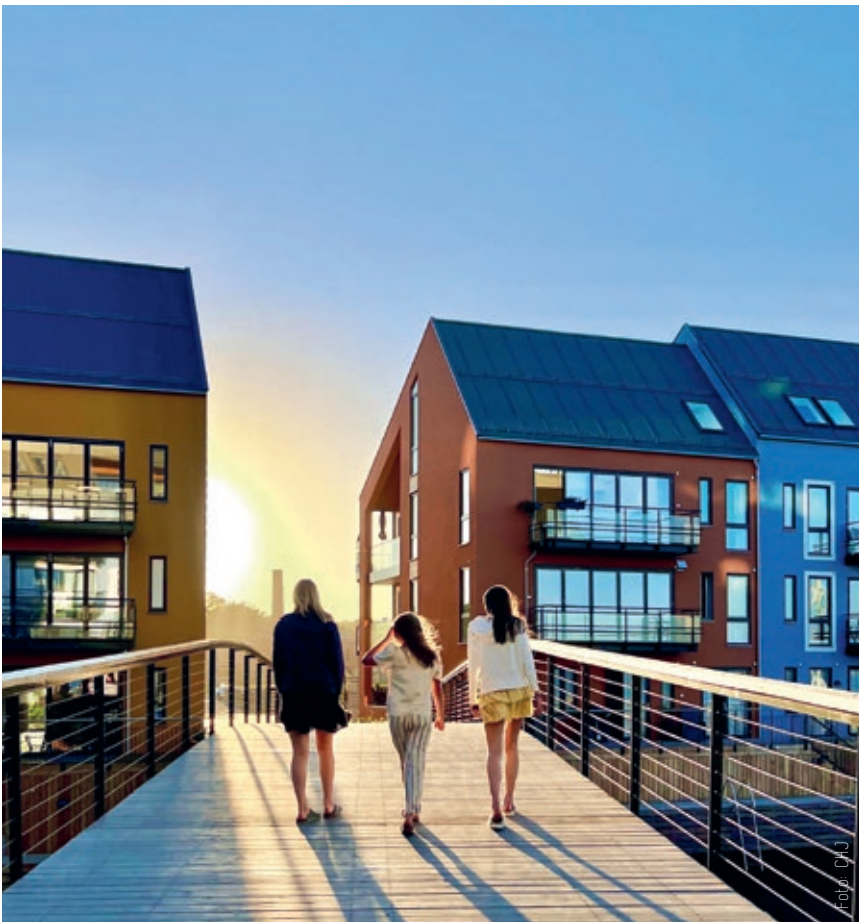
Fasadene måtte tåle tøft og rått klima med sjøsprøyt. Ønsket var vedlikeholdsfrie pussfasader, og valget falt på et luftet fasadesystem med puss på plate
