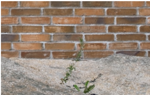
Forblendingen er murt i kvartsteinsforband med gjennomfarget murmørtel
