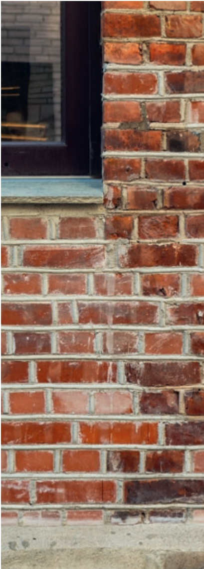
Utvendig ble fugene reparert med KC-mørtel. Foto: nispe@mac.com
