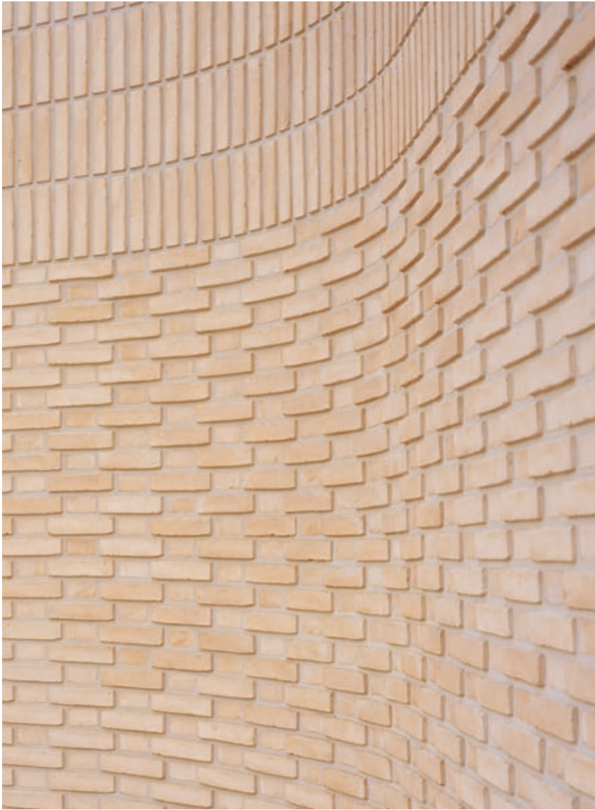
Fasadene er murt med Avignon tegl og lys murmørtel i polsk/gotisk forband med inntrukket kopp
