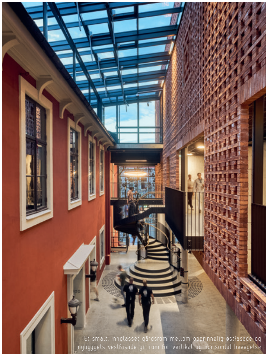
Gittermuren er en kombinasjon av prefabrikerte teglbjelker og frimurt teglstein
