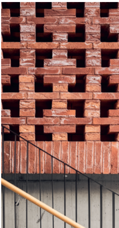
Gittermuren er en kombinasjon av prefabrikerte teglbjelker og frimurt teglstein
