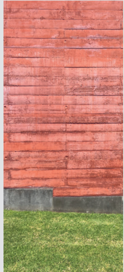
Bordforskalt betong. Foto: ES
