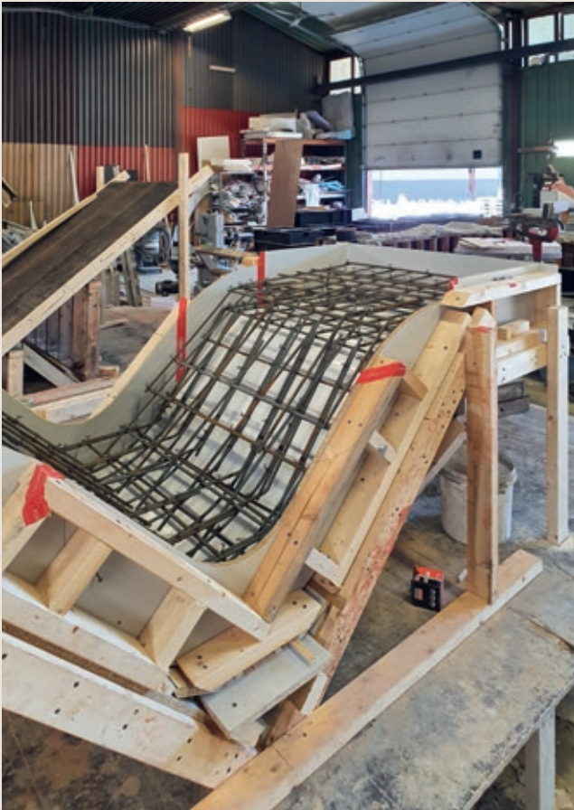
Alle deler av sitte-/liggeelementet er støpt i hvit betong tilsatt rødt og gult pigment for å få en oransje kulør
