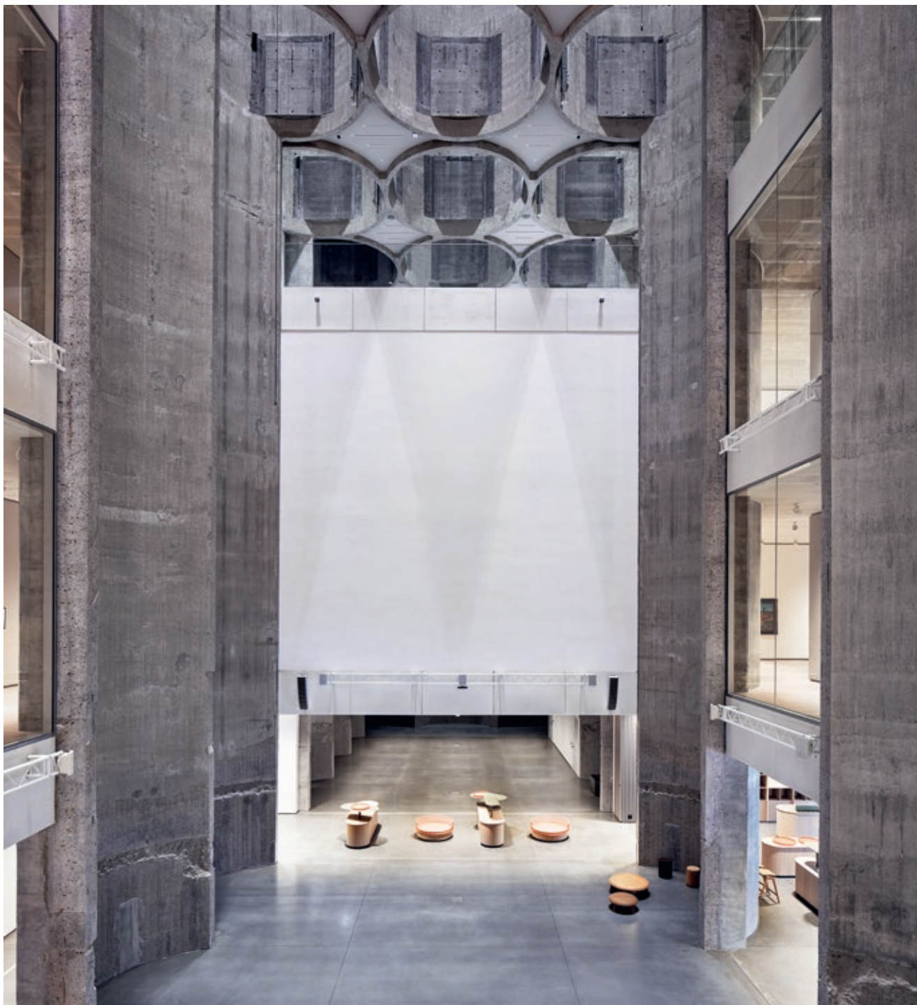
Silocellene ble kuttet horisontalt og vertikalt, bit for bit, med håndholdt sag. Totalt er det tatt ut rundt tre tusen tonn betong og stål
