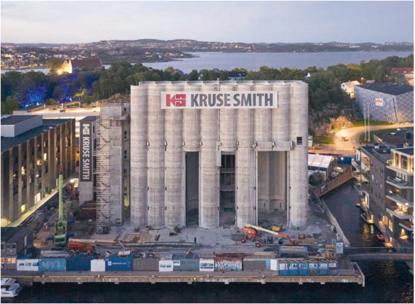
Både silotaket, elevatorkaset og havnelageret ble revet. Siloen ble forsterket med 20 cm betong på utsiden, utført som en ensidig glidestøp
