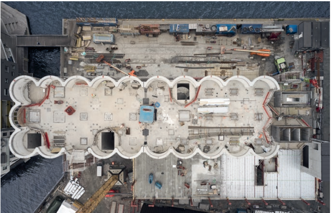
Både silotaket, elevatorkaset og havnelageret ble revet. Siloen ble forsterket med 20 cm betong på utsiden, utført som en ensidig glidestøp
