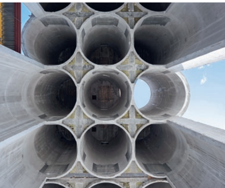
12 meter i toppen av de gamle betongsiloene er bevart. Disse henger 20 meter over bakken
