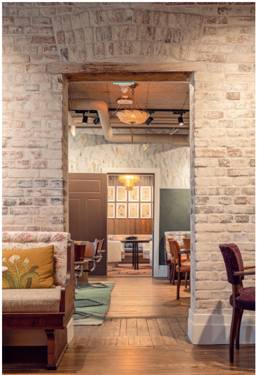
Romforløp i 2. etasje. Teglvegger med løs puss ble strippet ned og filset. I det innerste møterommet er originalt rupanel eksponert og behandlet med mørk hardvoksolje. Foto KS
