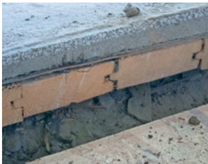
Frå prosessen: Snitt gjennom gulv med terrazzo, påstøp, kraftige gulvbord, halm og leire. Foto KW
