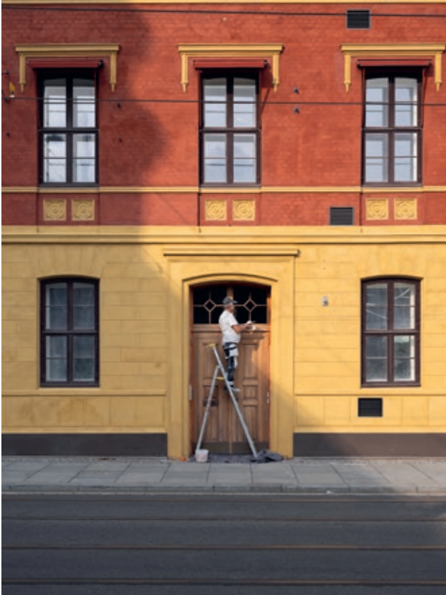
Fasaden er sekkeskurt, og det er benyttet sjablonger for å lage mønster i pussen. De originale fargene er tilbakeført med kalkmaling, og replikadør er satt i stand og remontert. Foto KW
