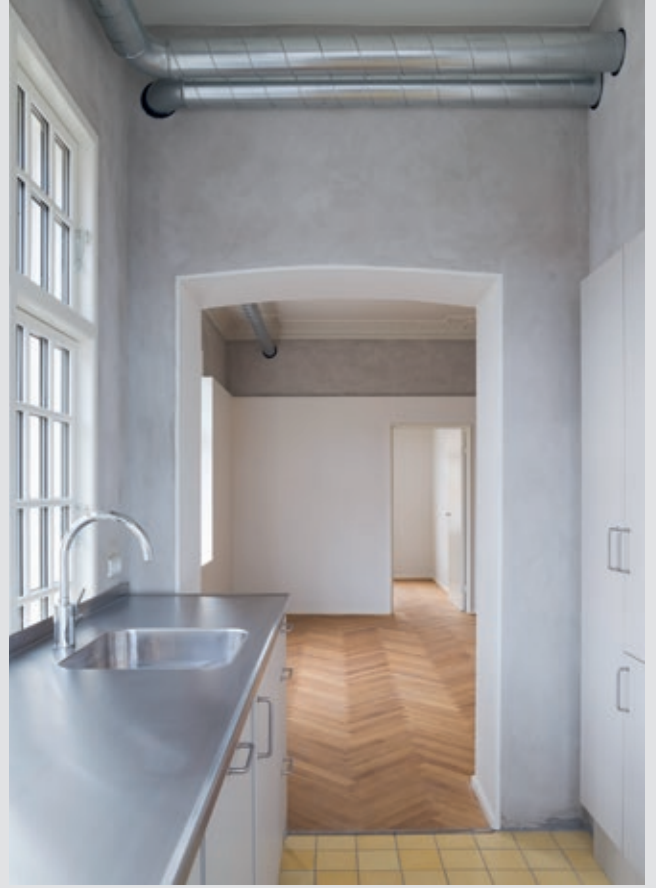
Der det er satt inn nye våtrom, benytter disse ikke full himlingshøyde, men lar gammel stukkatur løpe fritt over.
