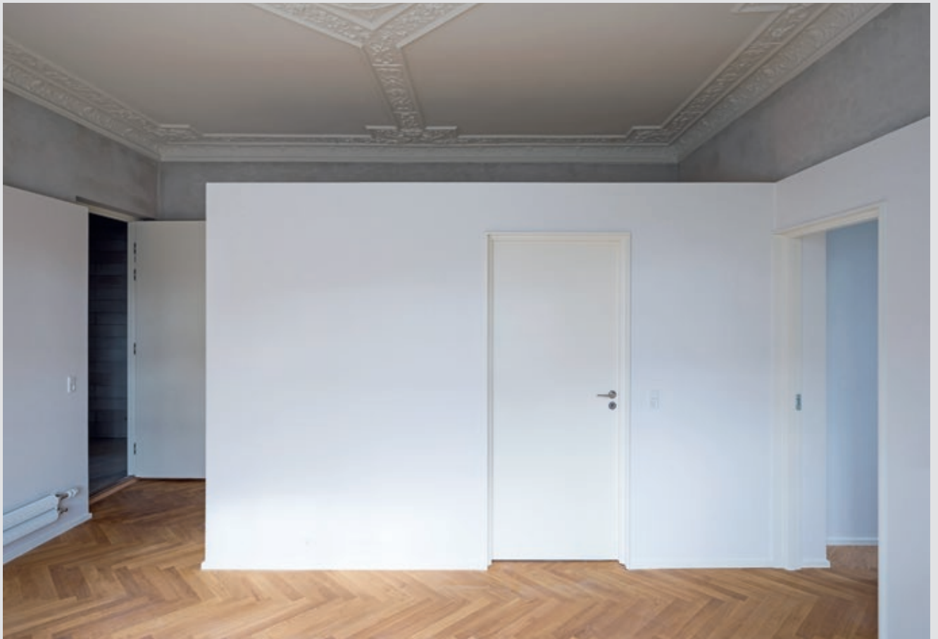
Der det er satt inn nye våtrom, benytter disse ikke full himlingshøyde, men lar gammel stukkatur løpe fritt over.
