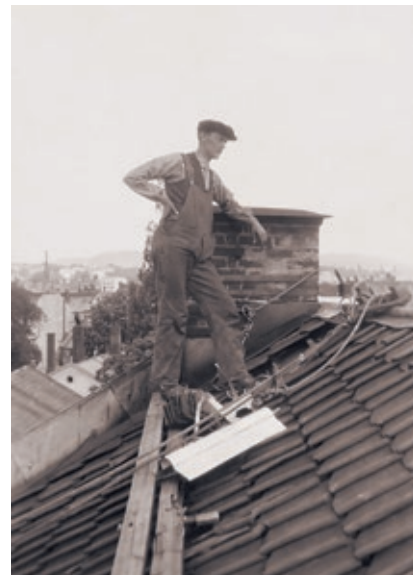
1933: En blikkenslager på taket av en bygård i Hegdehaugsveien 27, Oslo. Foto: Wilhelm Hassrød – Arbeiderbevegelsens arkiv og bibliotek – digitaltmuseum.no
