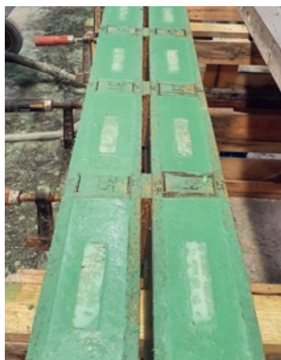
Etter utstøping, herding og avforming ble kanter og grader slipt ned før elementet ble behandlet med sealer
