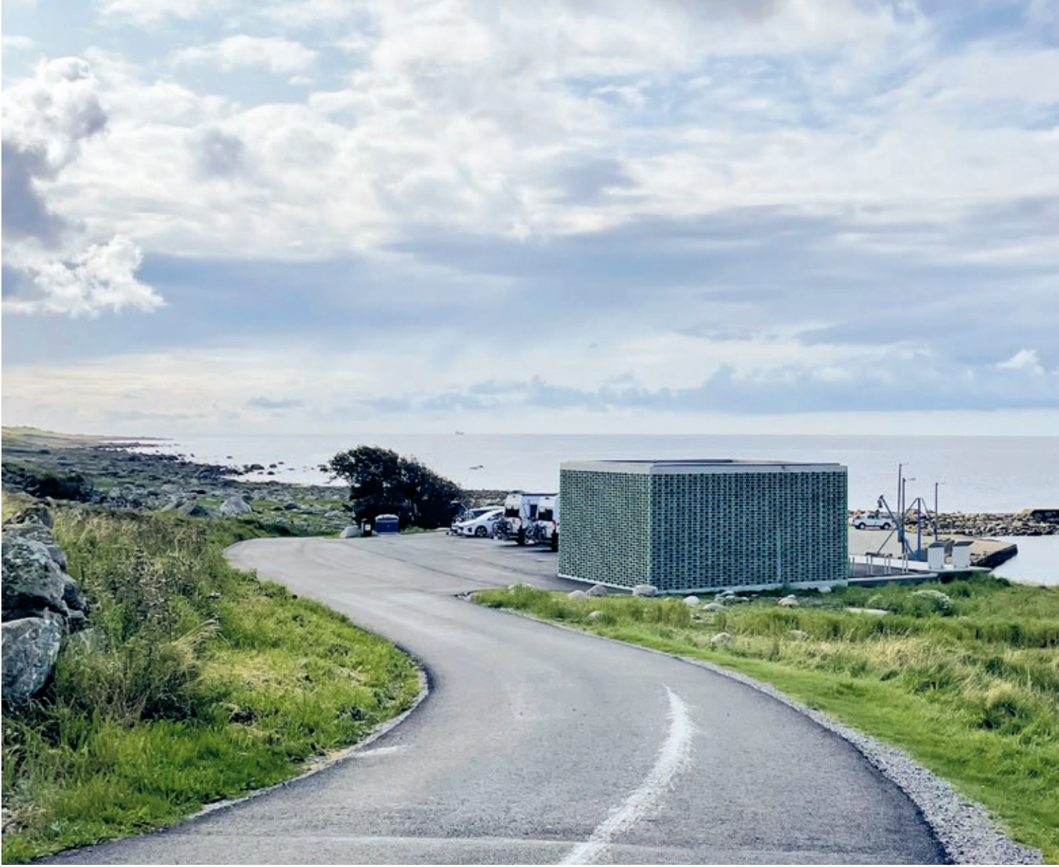
Servicebygget Lanternen ligger på utsiktsplatået. Det ytre skallet er bygget opp av grønne fasadeelementer i fiberbetong
