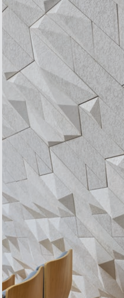
Keramiske paneler med relieff i konsertsalen (til venstre) og med 'blomster' i operaen (høyre) gir en rundere, varmere lyd
