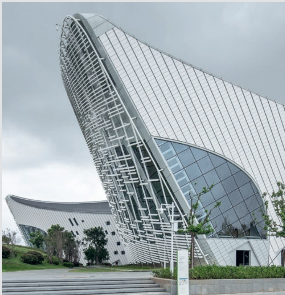
De linseformede keramiske fasadelamellene relaterer seg til formen på bygningskroppene
