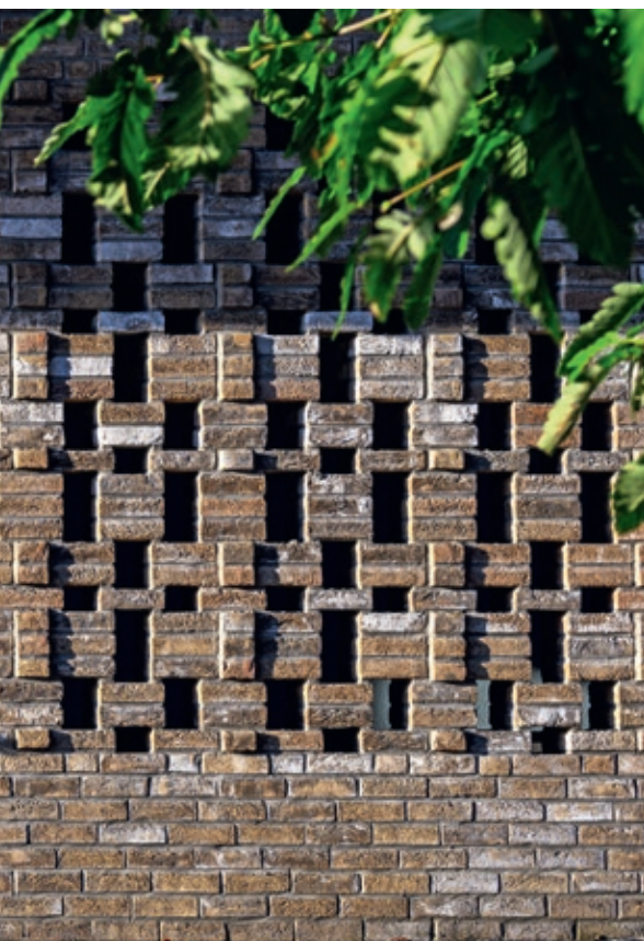
Flettverksmur ved inngangsparti i plan 1
