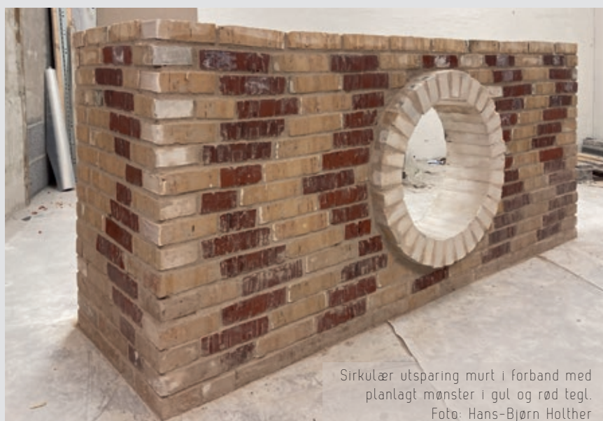
Utkragende forbant murt på sokkel av murblokk. Foto: Hans-Bjørn Holther
