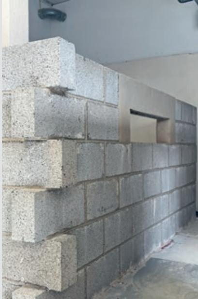
Studentarbeid med murblokker. Utsparing med armerte, pussede u-blokker. Foto: Hans-Bjørn Holther
