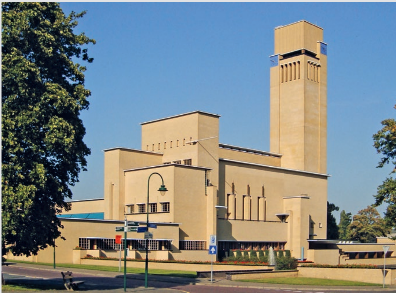
Rådhuset i Hilversum, Nederland av arkitekt Willem Marinus Dudok. 1927, er et av mange eksempler på bygninger hvor arkitektenes forståelse av byggemateriale og håndverk er en betingelse for den høye arkitektoniske kvaliteten, både estetisk og teknisk. Foto: Trotter/wikimedia
