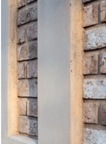
Treprofiler i formene og dybde til fugene i teglfeltene, og en duk og mørtelaktig tekstur i kontrast til den glatte betongen
