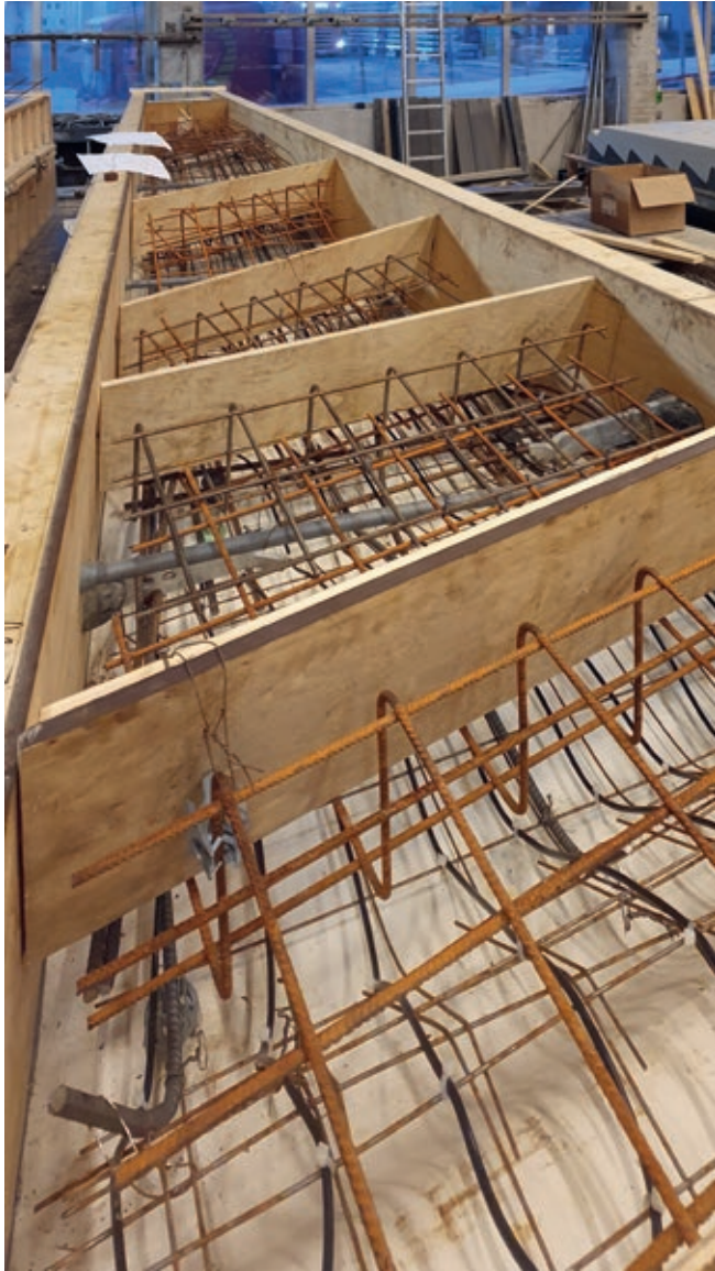
Elementene er støpt med B35MF40-betong med 6% sort pigment. Foruten tradisjonell stålarmering er det også brukt en komposittfiber. Alle elementer bortsett fra det aller minste har innstøpte varmekabler. Fire av de største elementene har også kanaler i overflaten for plassering av kassetter til LED-belysning
