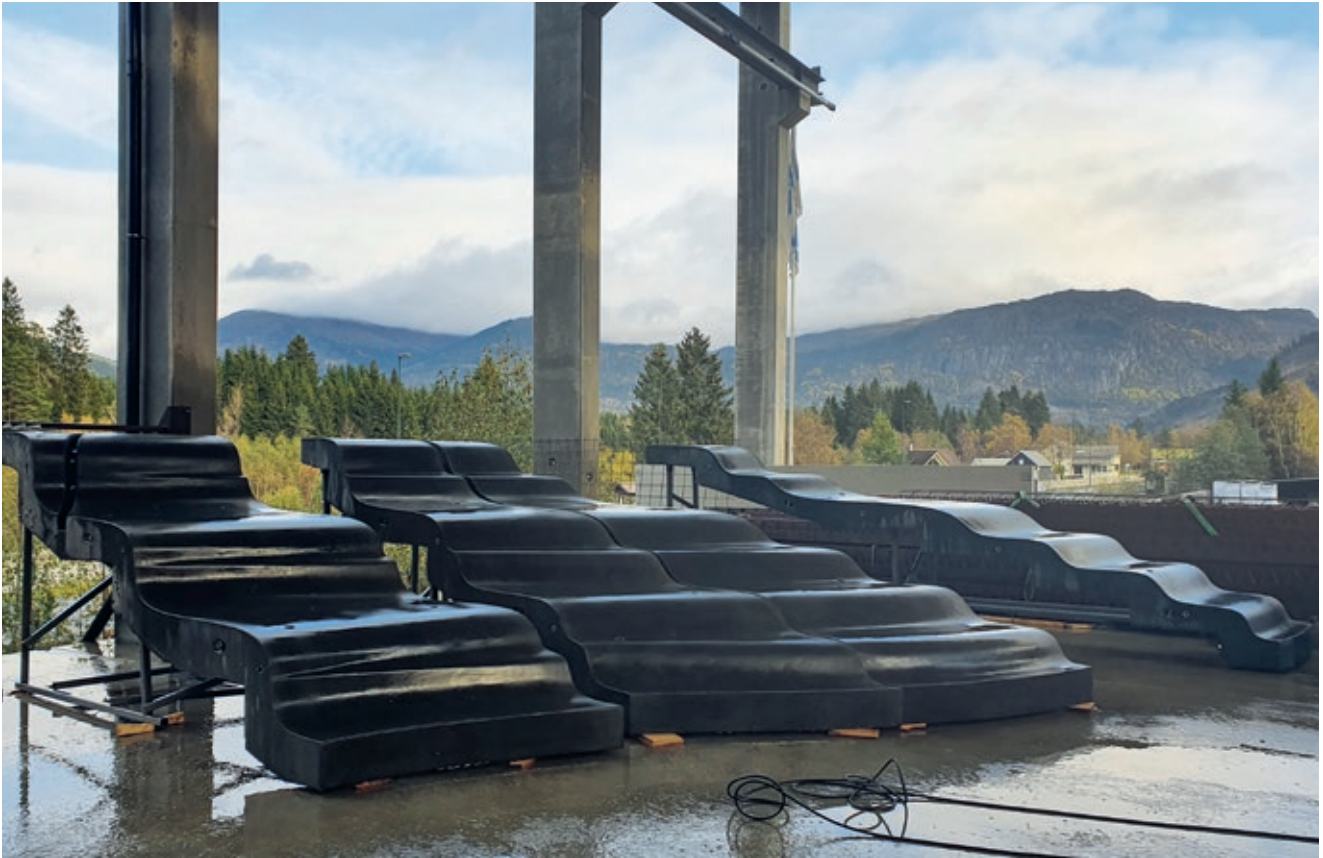
Stålbukkene som sørger for understøtting og riktig høyde ble tilpasset og fastsveiset ved testmontering
