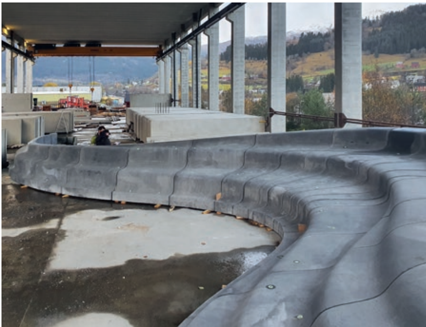
Ferdigstøpte elementer på fabrikk på Voss
