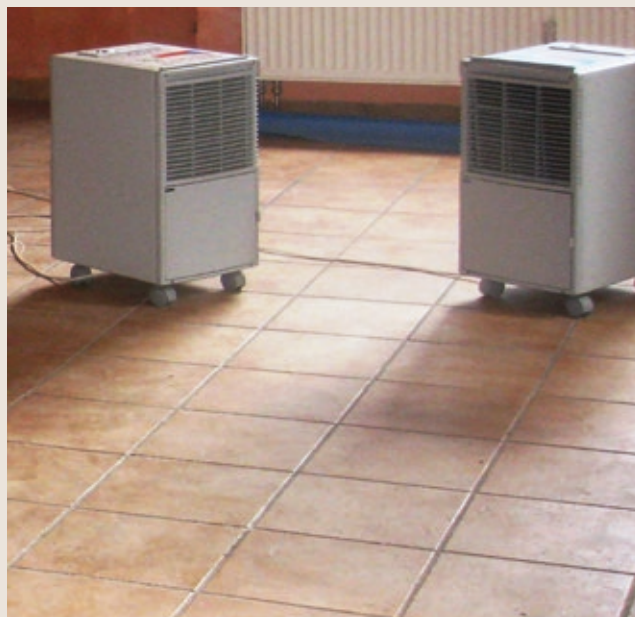
Figur 7: Det rengjorte gulvet fikk stå og tørke en stund og kunne så tas i bruk igjen
