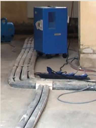
Figur 4: Trebaserete gulvmaterialer ble fjernet til ned på betongen og kraftige byggørkere ble brukt for fukt fjerning i rommet
