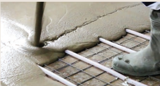
Figur 5: Selvutjevne gulvavretningsmasse blandet og lagt ut, straks klar til flislegging
