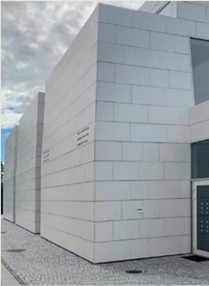
Figur 4: Fasadekledning mot plant terreng
