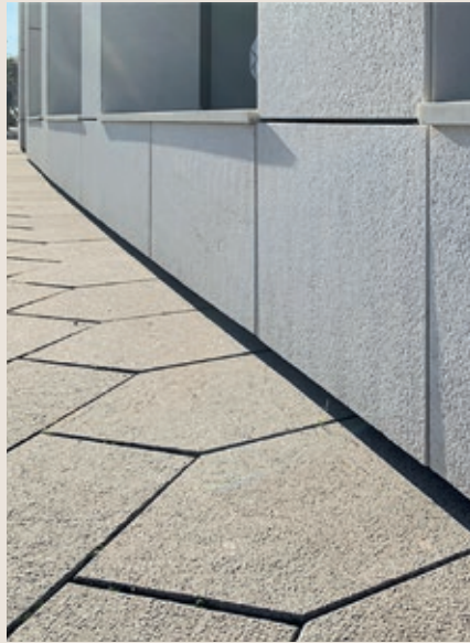
Figur 5: Sokkeltilpasning i skrått terreng. Vann må dreneres ut – og luft komme inn. Spalten under må enkelt kunne rengjøres
