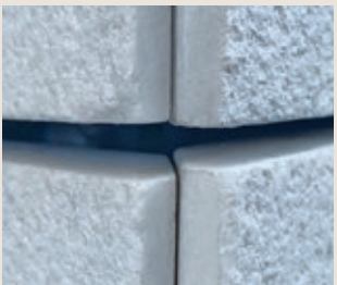
Figur 8: For å hindre skarpkant er steinen skråsaget slik at det blir et 'avrundet' hjørne
