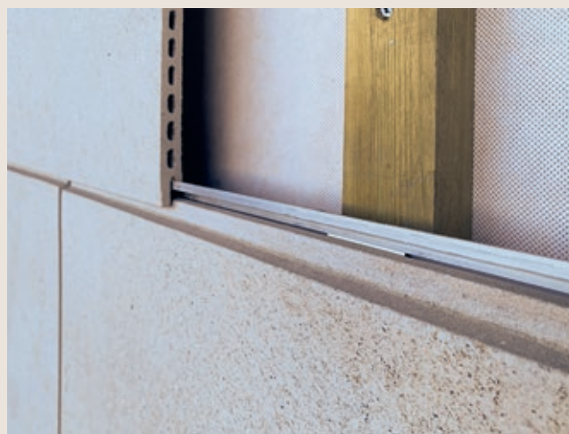
Figur 13: De fleste innfestingsystemene gir mulighet for finjustering av fugebredder for å unngå synlige variasjoner
