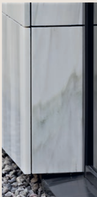
Figur 9: Hjørneløsning med hel flis i front og fugen lagt på smygsiden
