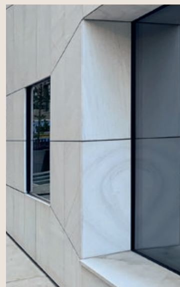
Figur 1: Luftede fliskledninger gir mange muligheter i utforming av detaljer
