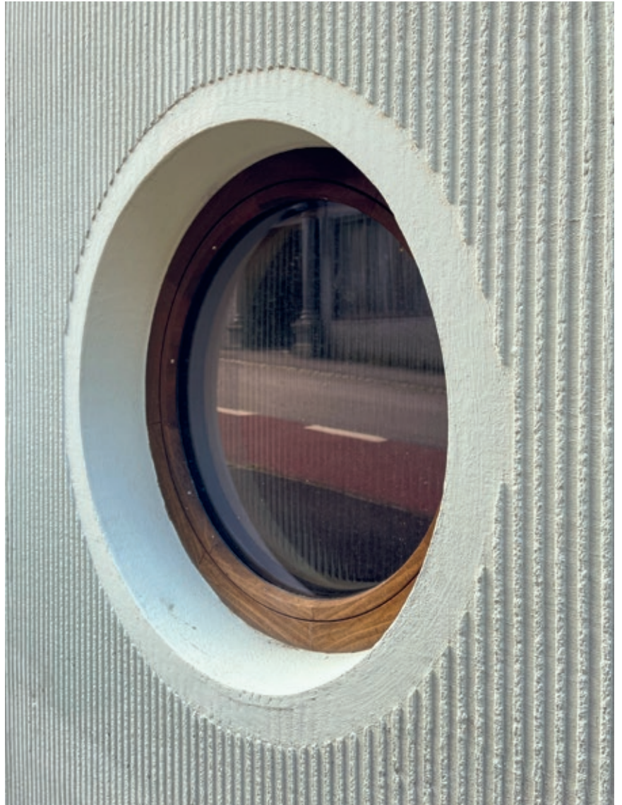
Den gjennomfargede slutt pussen ble trukket på med tannsparkel
