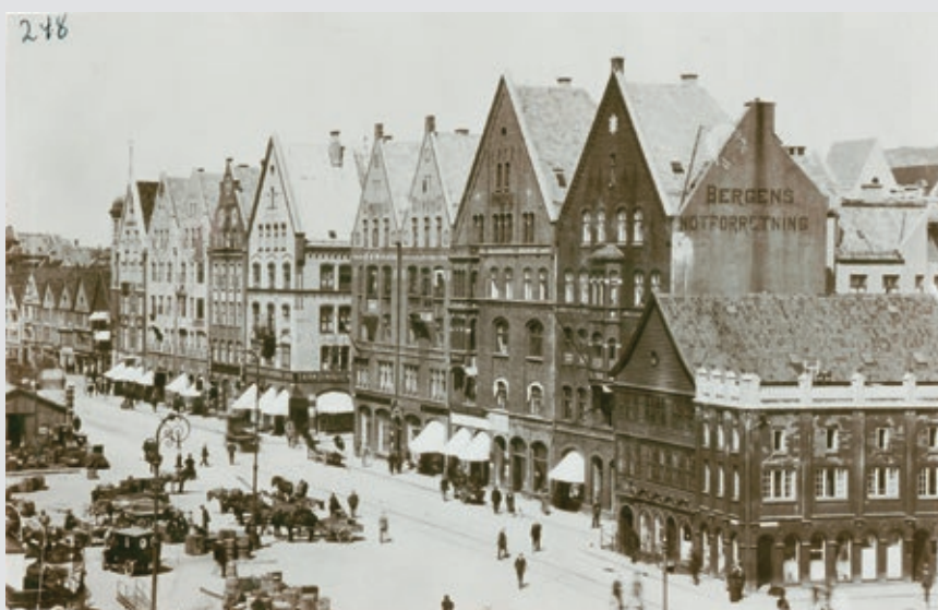
Murbryggen: Frem til 1901 utgjorde området mellom Dreggsallmenningen i nord og Kjøttbasaren i sør en sammenhengende rekke handelsgårder i tre som var gjenreist etter bybrannen i 1702. Handelsgårdene sør for Nikolaikirkeallmenningen ble da revet og erstattet med bygårder i mur i samme stil, tegnet av Jens Zetlitz Monrad Kielland. Kilde: wikimedia. Foto: Riksantikvaren (wikimedia)
