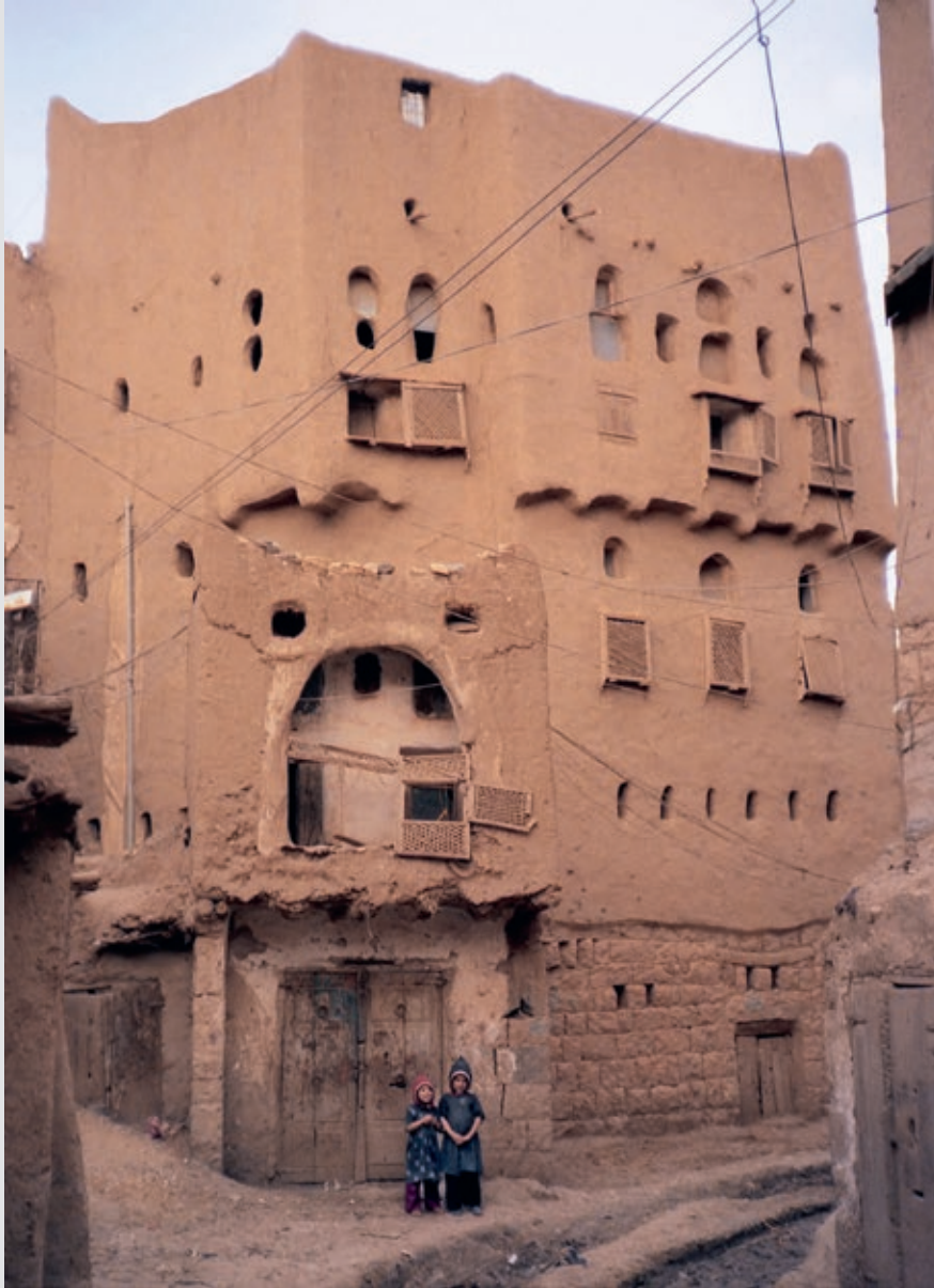
Et flere etasjers adobehus i byen Amran i Jemen, hvor trebjelkene i etasjeskillet krager ut. Med tanke på den lett eroderbare adobepussen, er det interessant å legge merke til de velutviklede vannutspyerne fra takterrassen. Disse leder takvannet langt ut fra fasaden slik at denne ikke skal gå i oppløsning ved store regnskyl. Foto: Gagnon, wikimedia
