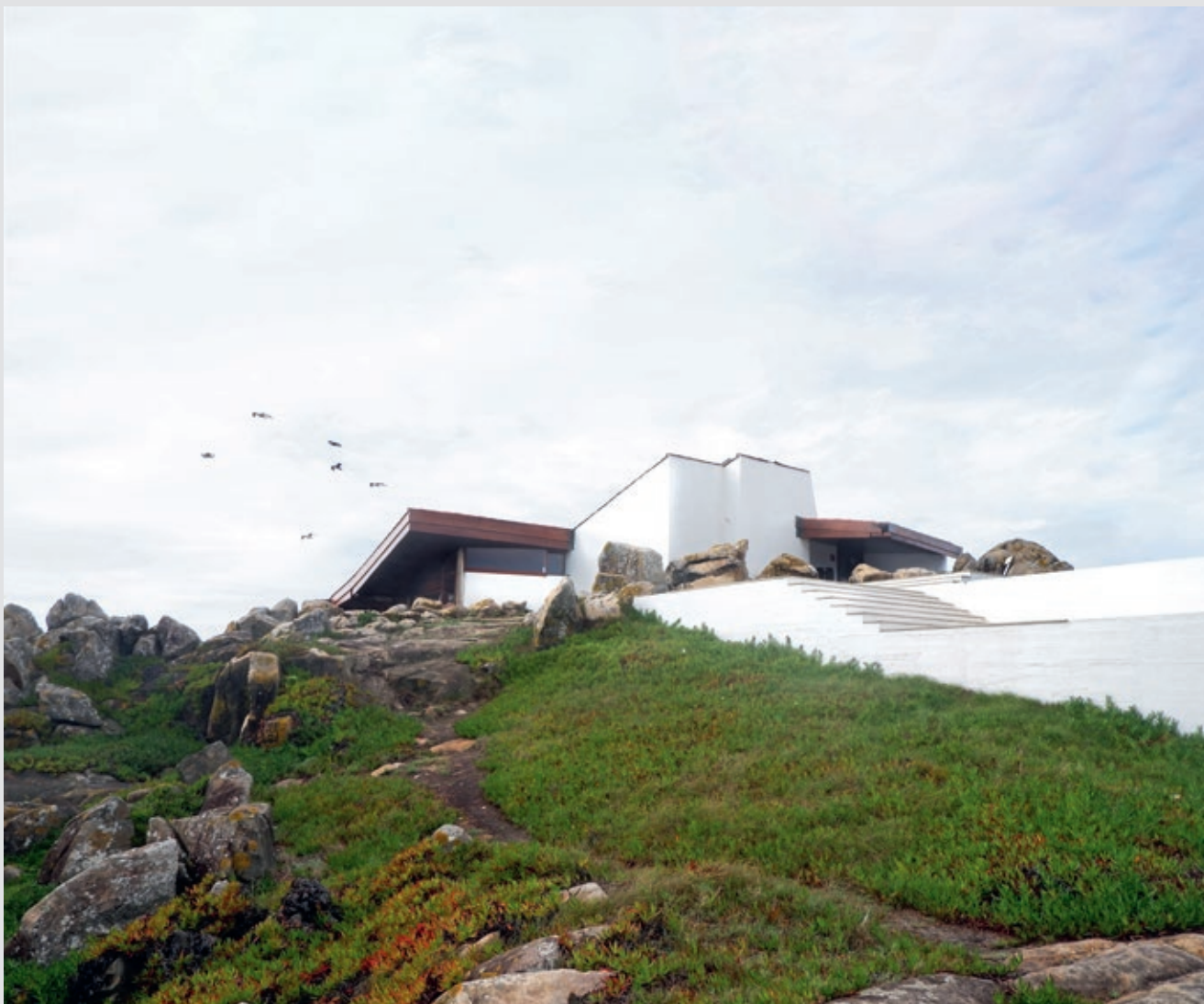
Restauranten Casa de Chá da Boa Nova, Av. Liberdade 1681, 4450-718 Leça da Palmeira
