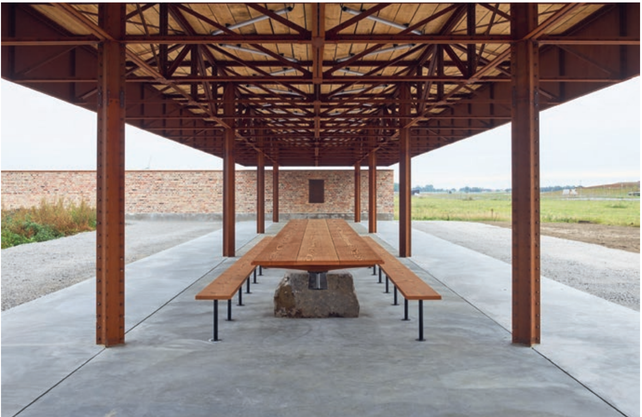
Den åpne siden av innhegningen vender mot sydøst og er beskyttet av en 43,2 x 7,2 meter stor baldakin i cortenstål Under baldakinen står et langt trebord med to benker
