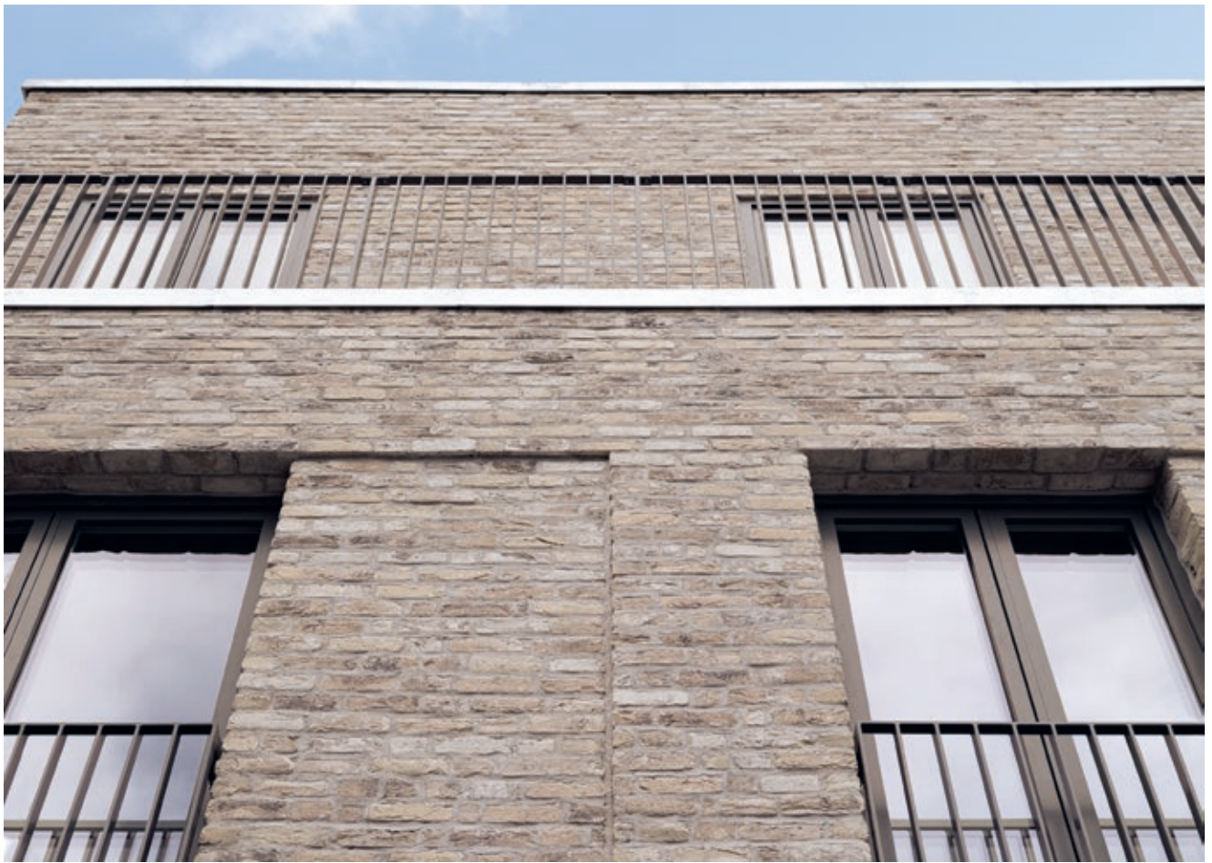
Nybygget – relieff og ulik dybde på vinduene gir variasjon i fasadene. Det ble valgt en lys, varm teglstein i vilt forband. Grunnteglen er lys gul med innslag av mørkere tegl, tromlet med sementslurry
