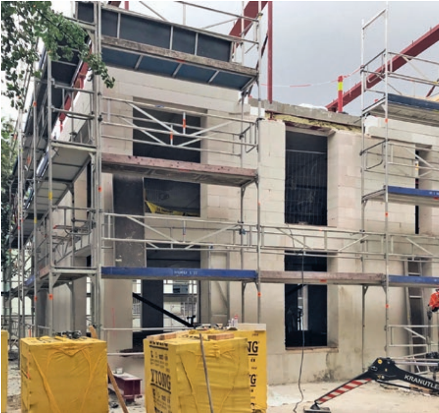
Smale teglstein er limt rett på porebetongen som en integrert del av murfasadene
