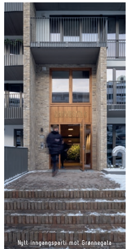
Nybygget – relieff og ulik dybde på vinduene gir variasjon i fasadene. Det ble valgt en lys, varm teglstein i vilt forband. Grunnteglen er lys gul med innslag av mørkere tegl, tromlet med sementslurry
