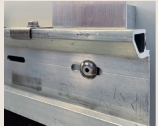
Figur 7: Horisontale bæreprøfer med avlange hull, slik at innfestingen kan ta opp lengdebevegelser
