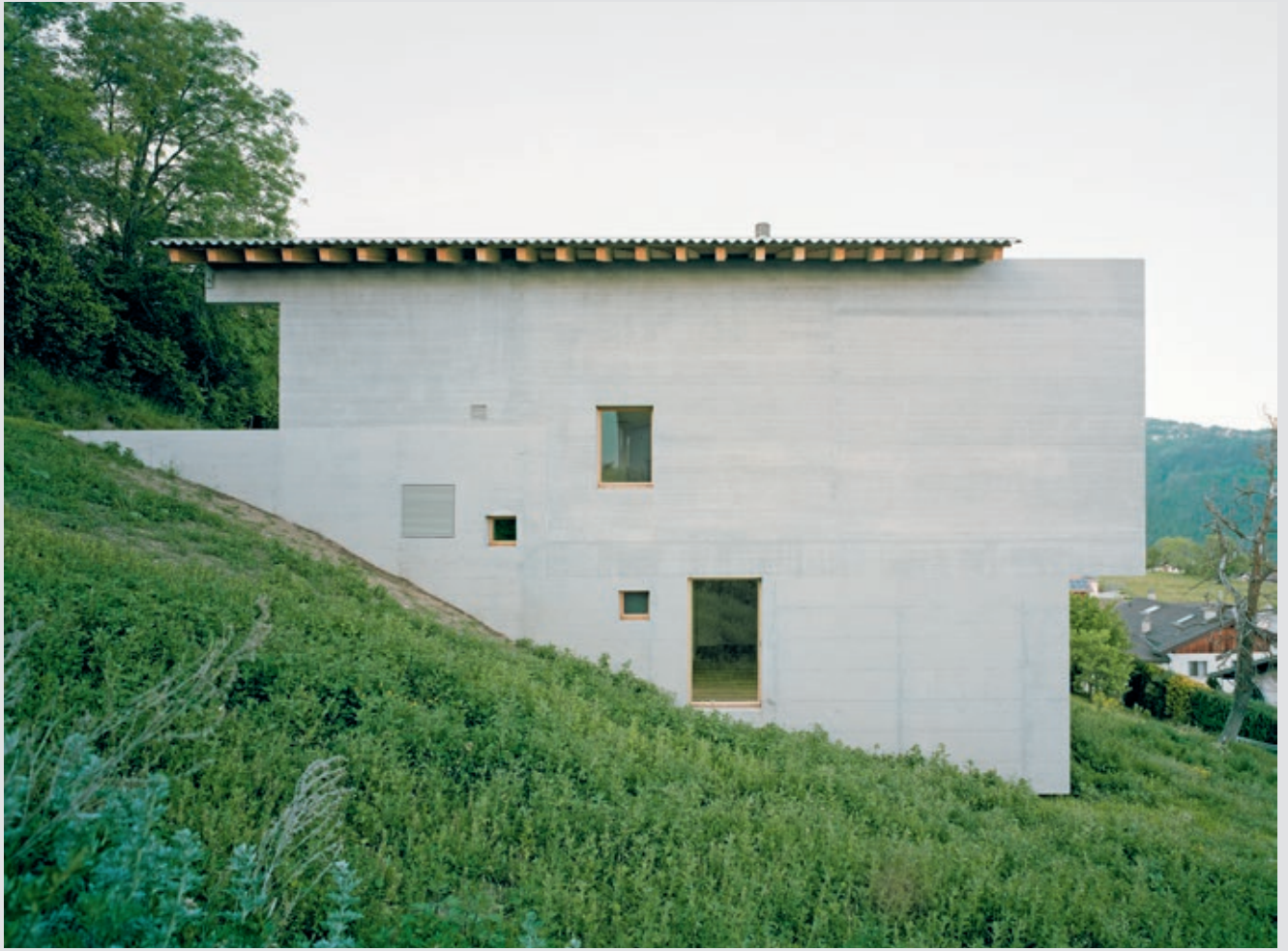
Takkonstruksjonen i tre er åpen i begge gavlene. Bæreveggene strekker seg forbi taklengden på en måte som man gjerne ser i tropisk modernisme
