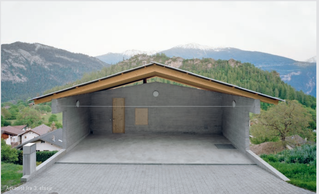
Takkonstruksjonen i tre er åpen i begge gavlene. Bæreveggene strekker seg forbi taklengden på en måte som man gjerne ser i tropisk modernisme
