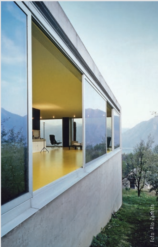
Livio Vacchini: egen bolig i Costa, Tenero-Contra, Ticino, Sveits, 1992. Kjernen med bad og kjøkken deler boarealet i to, med spisestue på den ene siden og stue og soverom på den andre. Gulvet er belagt med kromgul polyuretan. Kilde: www.studiovacchini.ch
