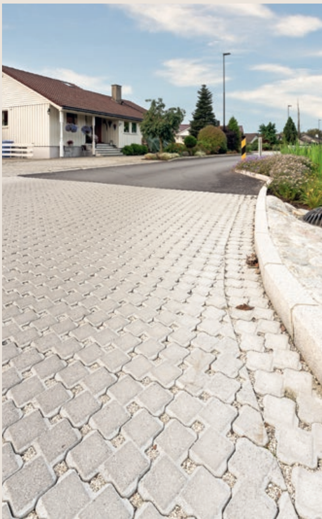
Kombinasjon av tett dekke på kjørearealer og permeabelt dekke på parkeringsarealer. Foto: Skjæveland Gruppen
