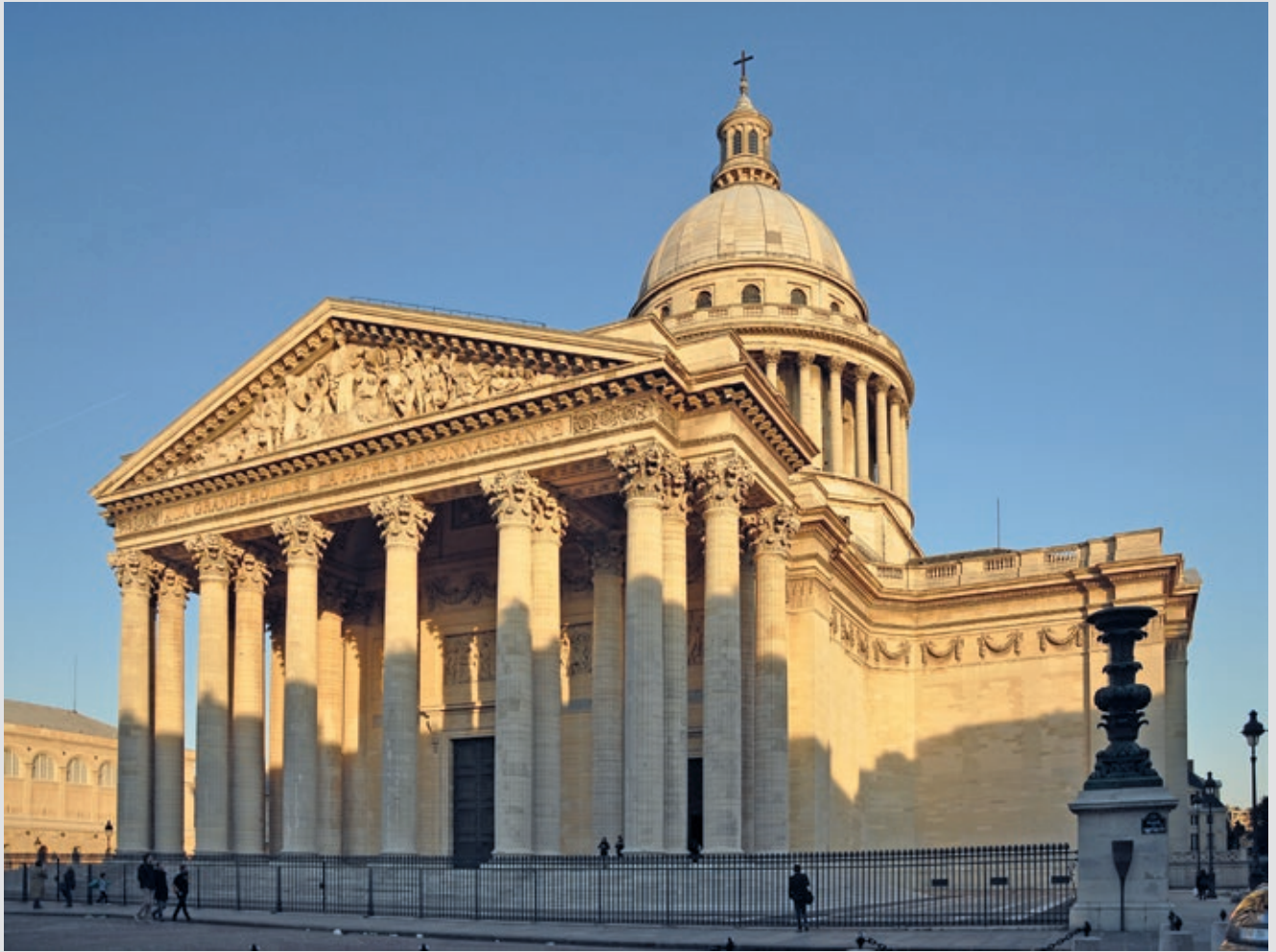
Panthéon i Paris 1758–1790 av Jacques-Germain Soufflot og Jean-Baptiste Rondelet. Bygningen ble opprinnelig planlagt som kirke, men er i dag nasjonalt mausoleum. I sideveggene kan man skimte Soufflots opprinnelige store lysåpninger som er gjenmurt. (Bygningen bakerst til venstre er et annet sentralt byggverk i utviklingen av ny bygningsteknologi: Biblioteket Sainte-Geneviève av Henri Labrouste fra 1851). Foto: Moonik/wikipedia
