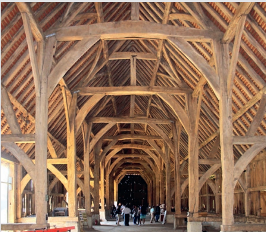
Grindverk ble ikke bare benyttet i Norge. Harmondsworth Great Barn ved Heathrow i London fra ca. 1420 har fortsatt den originale konstruksjonen. Foto: Stig Rune Pedersen. Kilde: lokalhistoriewiki
