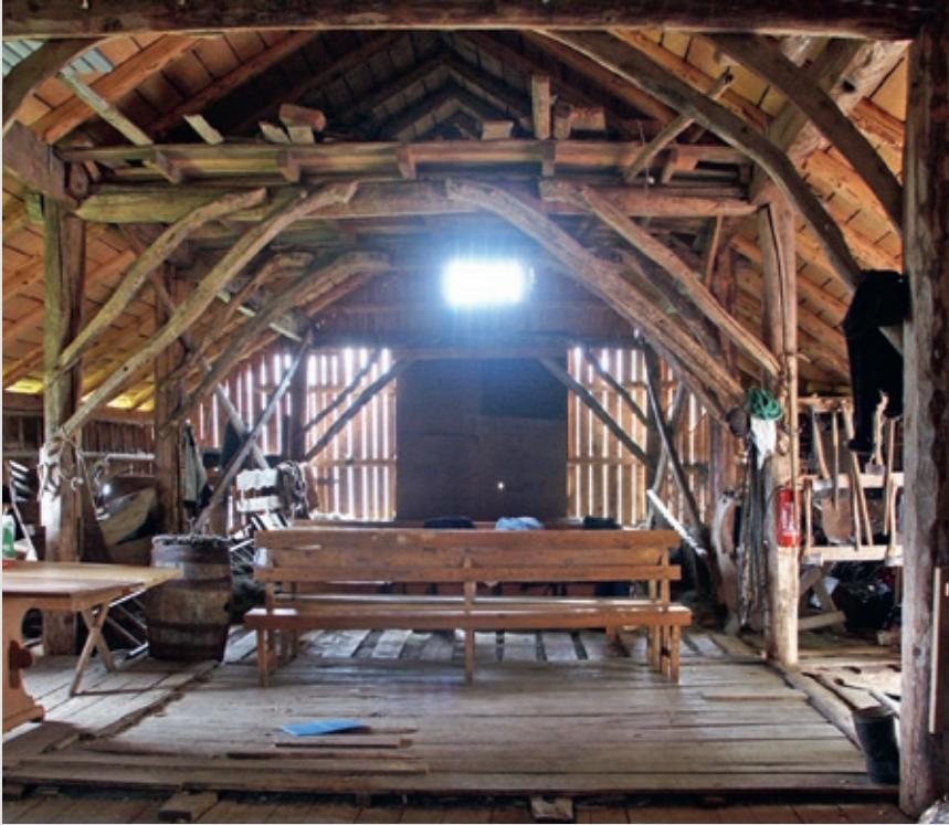
Grindverk er en byggeteknikk basert på grunder satt etter hverandre på tvers av byggets lengderetning og bundet sammen på langs av bygningen. Det er en gammel byggeteknikk i Norge særlig brukt i uthus som naust og låver på Vestlandet. Her en grindverkskonstruksjon fra Ytste Skotet, Sunnmøre. Foto: Frode Inge Helland. Kilde: wikipedia
