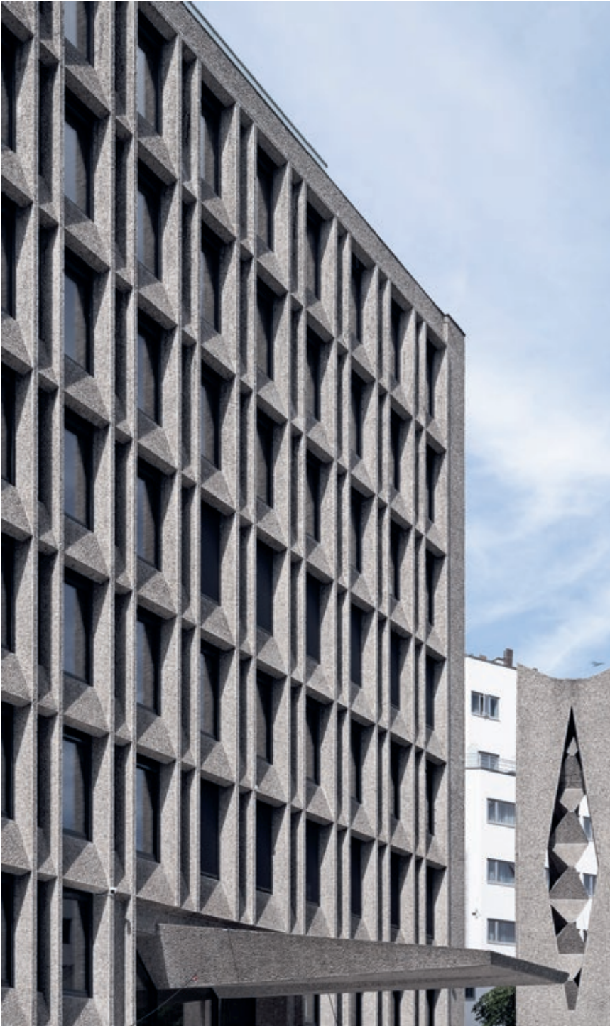
Den rasterformede fasaden i natubetong er som ny etter fasadevask. Den tolv meter høye skulpturen 'Tetraeder' av Ramon Isern markerer inngangspartiet
