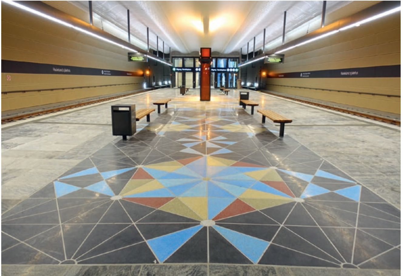
'Teppe' på perrongen er satt sammen av gjennomfargede trekantede betongheller
